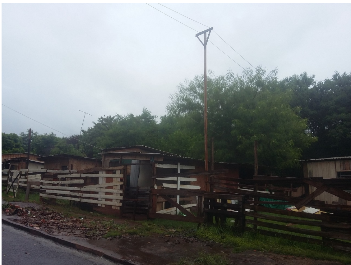
Foto 4 - Vista parcial de domicílios improvisados, localizados na Rua Ana Caputo Piacentini, Conjunto Habitacional Aquiles Stenghel na porção norte da cidade
