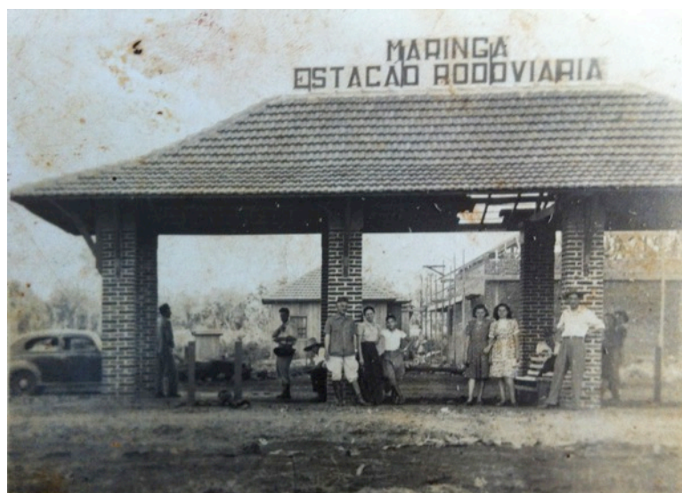
Figura 2 - Estação rodoviária no “Maringá Novo”. “Praça da Rodoviária”, atual Napoleão Moreira da Silva, 1949
