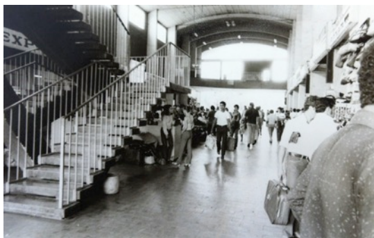
Figura 20 - Escadaria e saguão no interior da Estação Rodoviária Municipal Prefeito Américo Dias Ferraz , década de 1980
