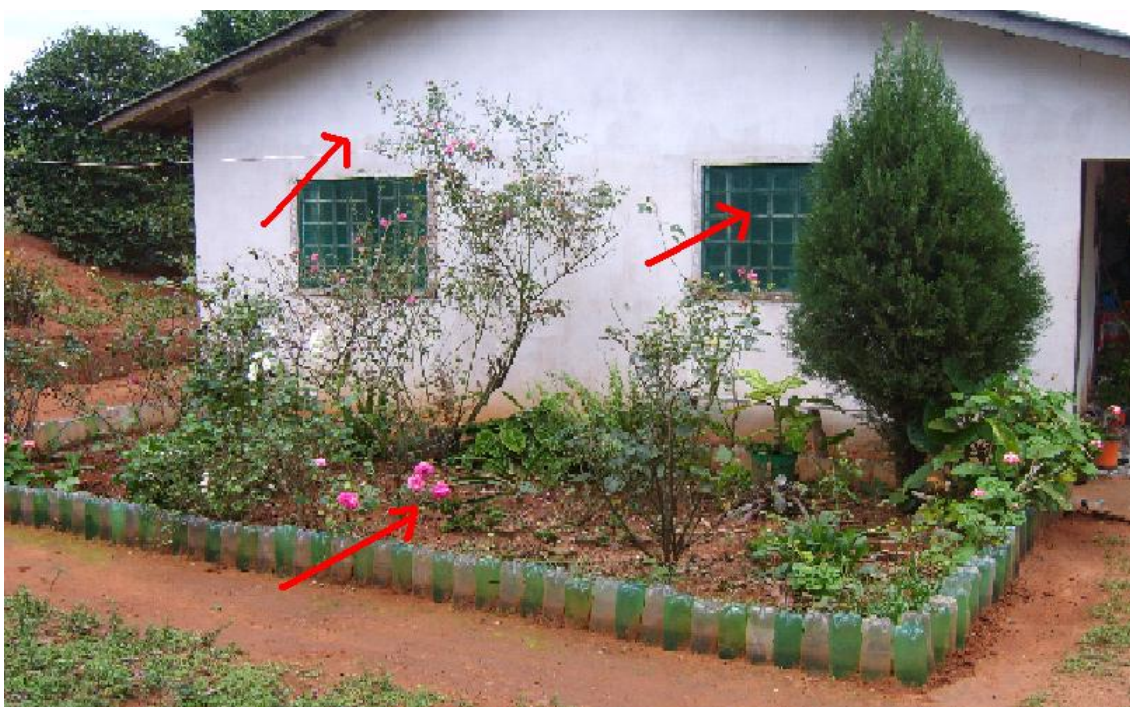
Figura 23: Residência reformada, com recursos próprios- Foto: L.F.M.B. (2009)
