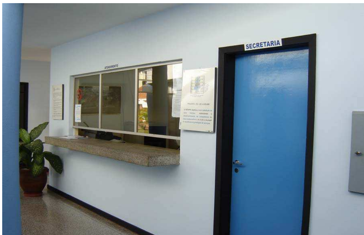
Figura 16. Vista externa da secretaria
