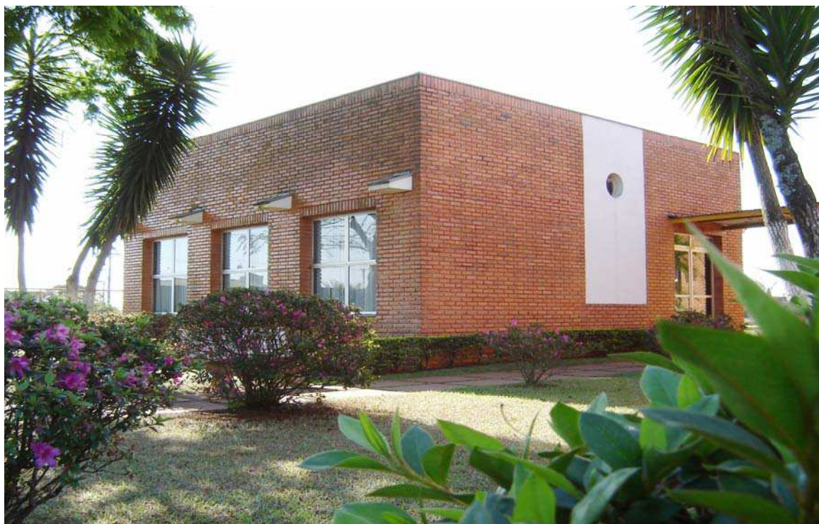
Figura 17. Vista externa do auditório
