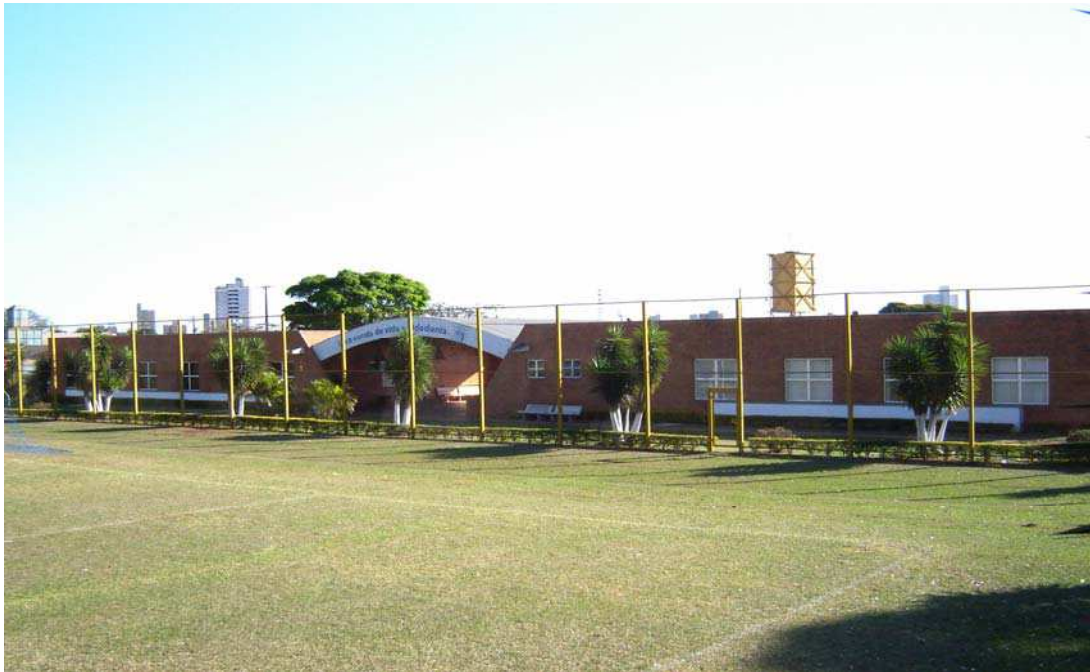
Figura 6. Vista da instituição pelas arquibancadas do campo de futebol
