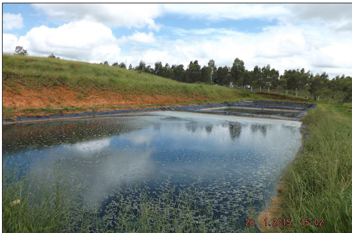
Figura 11 - Lagoas de retenção de chorume do aterro sanitário Cias Joaquim Távora
