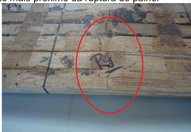
Figura 59 - Detalhe mais próximo da ruptura do painel
