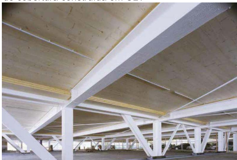
Figura13 – Laje de cobertura construída em CLT
