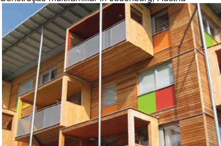
Figura 11 - Construção multifamiliar in Judenburg, Austria
