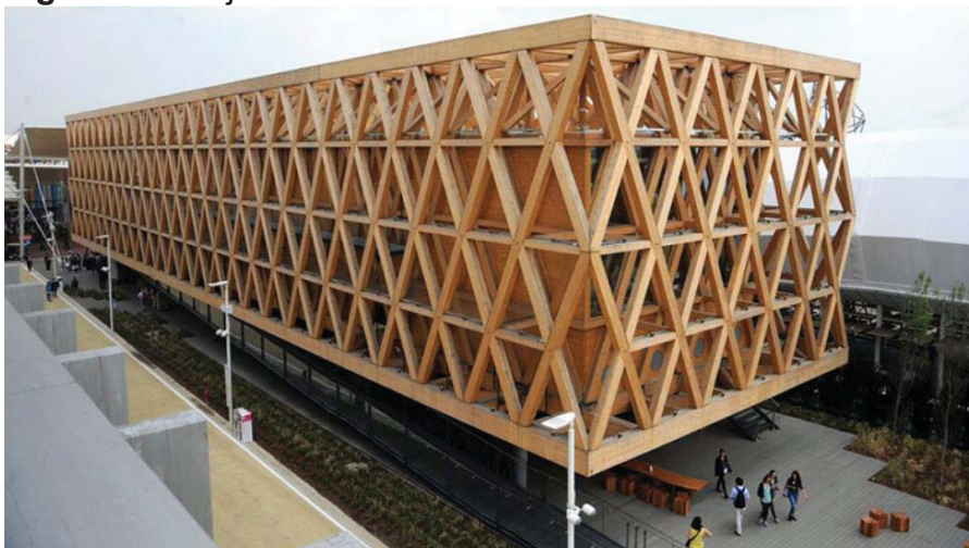
Figura14 – Laje de cobertura construída em CLT
