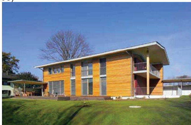
Figura 6 - Edificação construída em CLT – Single-Family house in Klagenfurt, Áustria (KLH, 2008)
