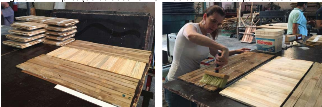
Figura 51 - Aplicação do adesivo MUF nas camadas dos painéis de CLTB
