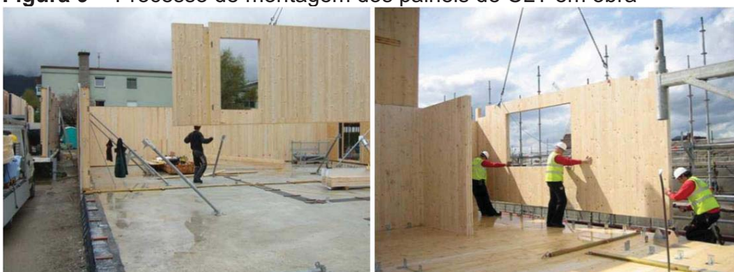
Figura 9 - Processo de montagem dos painéis de CLT em obra
