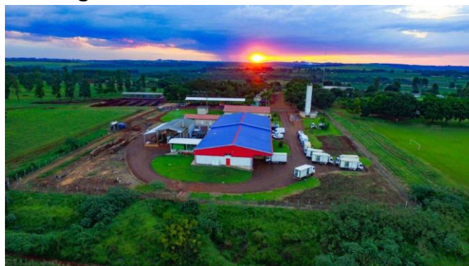
Figura 14 - Vista aérea da COPRAN
