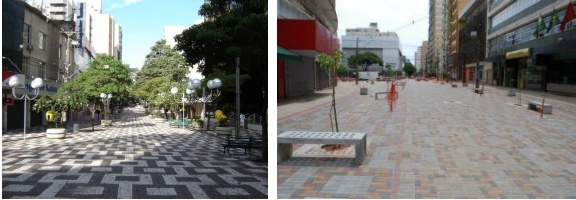
Figura 4: Calçadão antes e depois da reforma.
