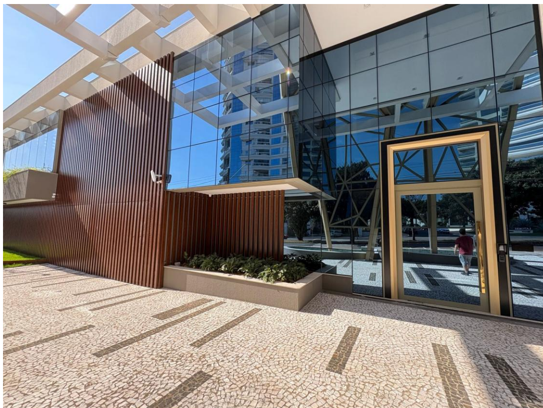
Figura 42 - Fachada do Edifício Wave destacando a porte-cochère
