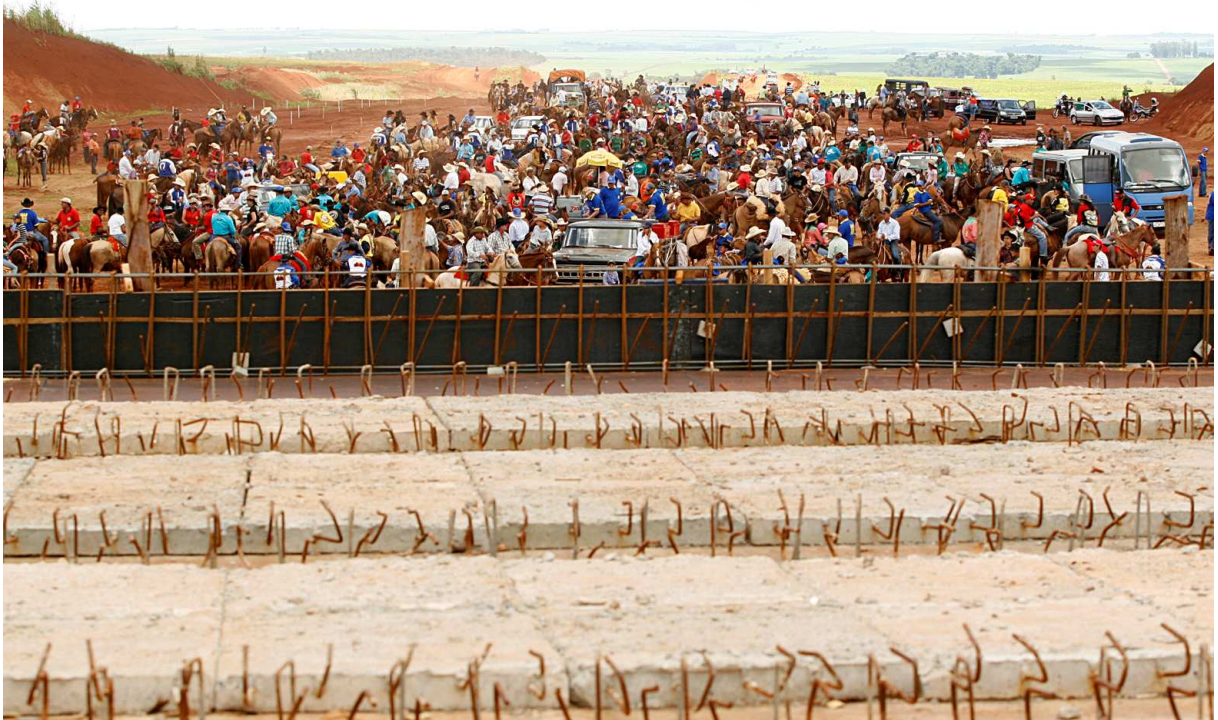
Figura 17 – Cavalgada e viaduto 1 Fotografia - André Renato/PMM
