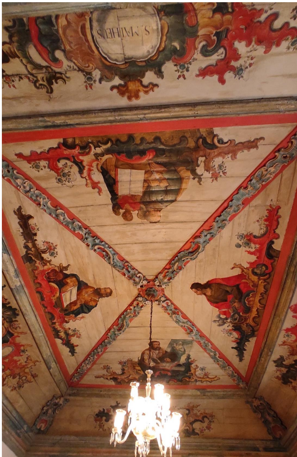
Figura 62: Detalhe do forro da sacristia da Igreja Matriz Nossa Senhora do Pilar, São João del-Rei, MG. Fonte: acervo pessoal
