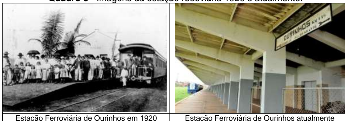
Quadro 3 - Imagens da estação rodoviária 1920 e atualmente.
