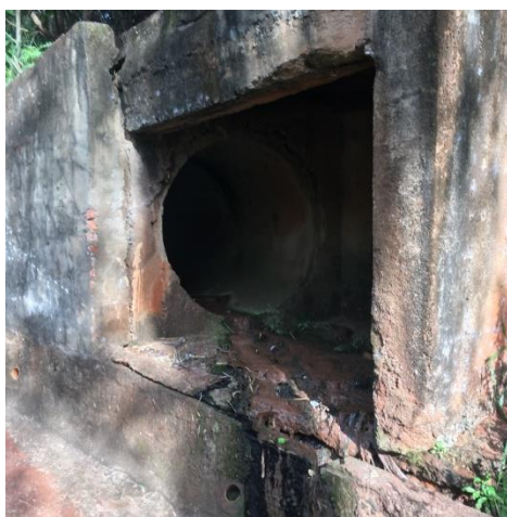
Figura 5.17 - Galeria de águas pluviais na parte superior da nascente 2b
