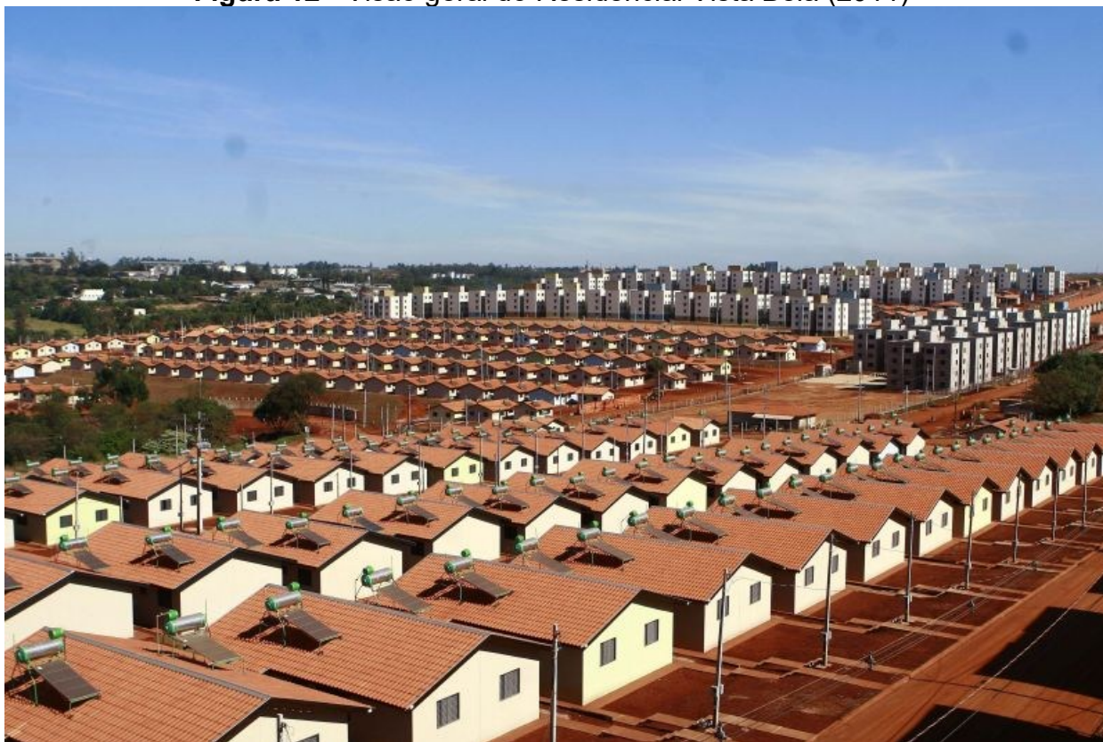
Figura 12 - Visão geral do Residencial Vista Bela (2011)
