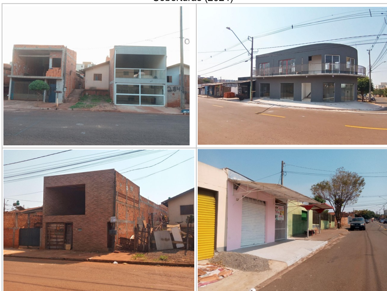
Figura 26 - Residencial Vista Bela - Verticalização dos Imóveis e Execução de Coberturas (2024)
