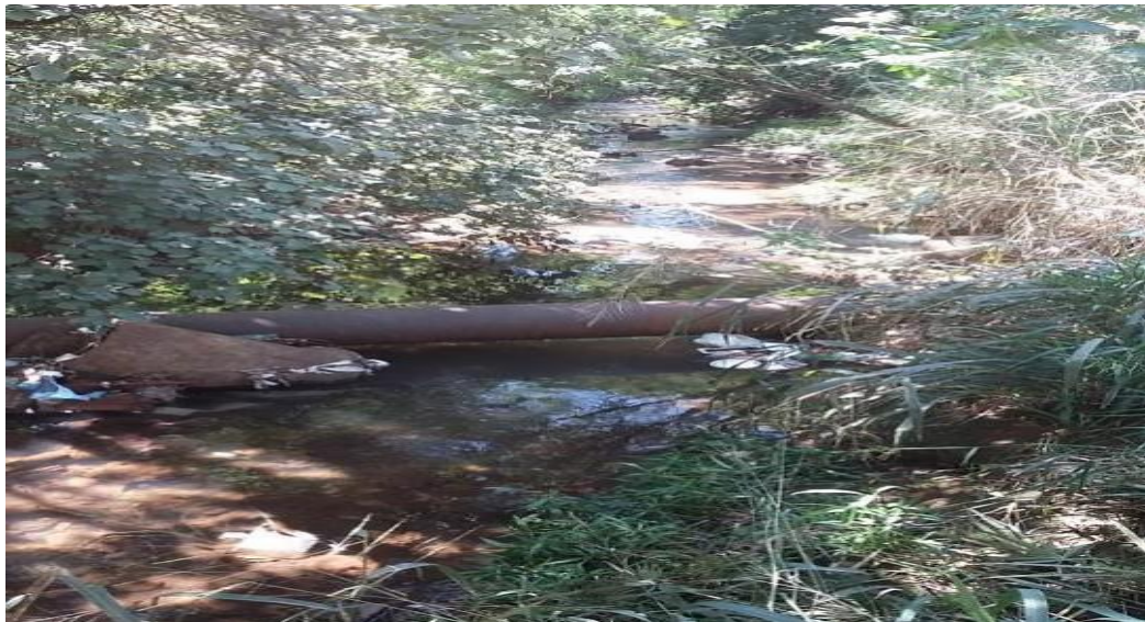
Figura 18 – Vista parcial do Córrego Água das Pedras a partir da ponte para o lado esquerdo.
