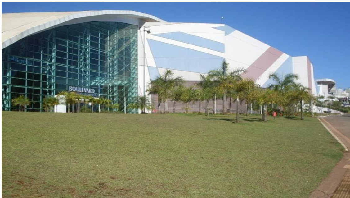
Figura 16 – Parte frontal do Boulevard Londrina Shopping Center Center . Avenida Theodoro Victorelli.
