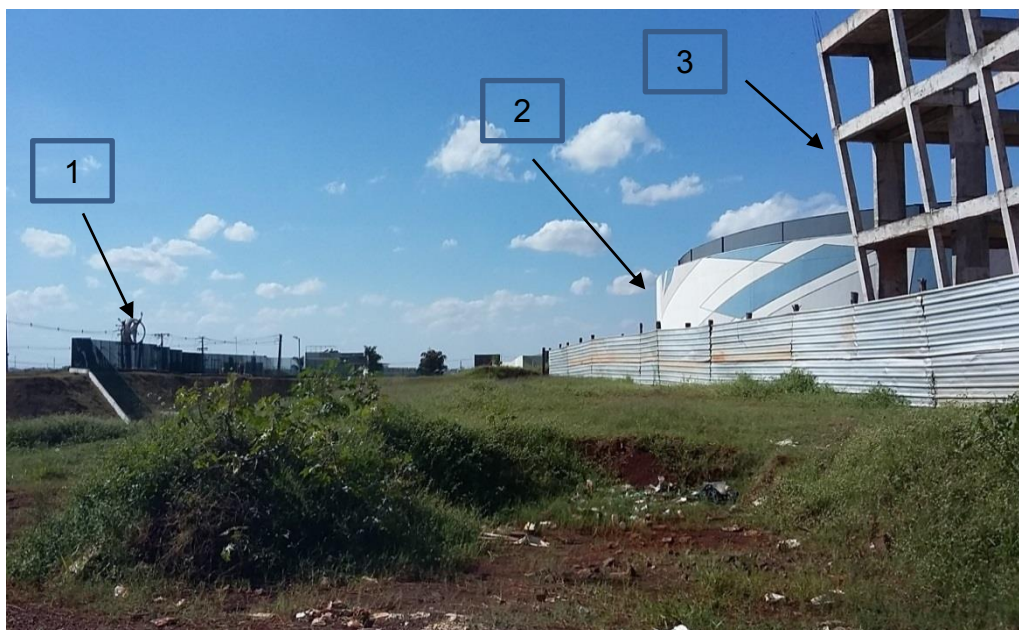
Figura 42 – UP2-SUB 2. Vigas Estruturais do Teatro Municipal
