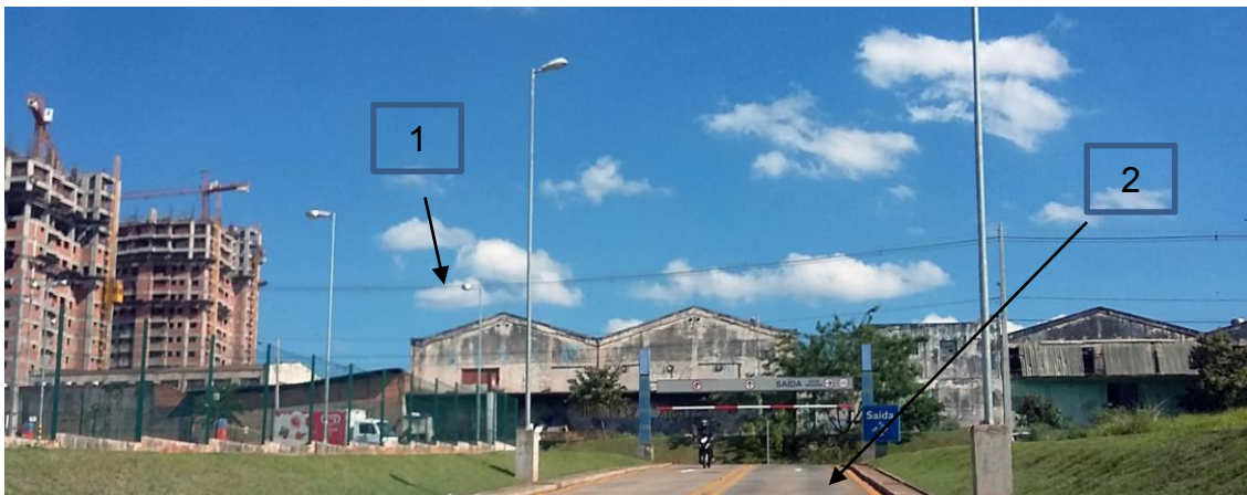
Parte sul do Complexo Empresarial Marco Zero. Uma das saídas do Londrina Boulevard Shopping Center . Os galpões e prédios em construção estão localizados na Av. Celso Garcia Cid. PINHEIRO, 2016.
