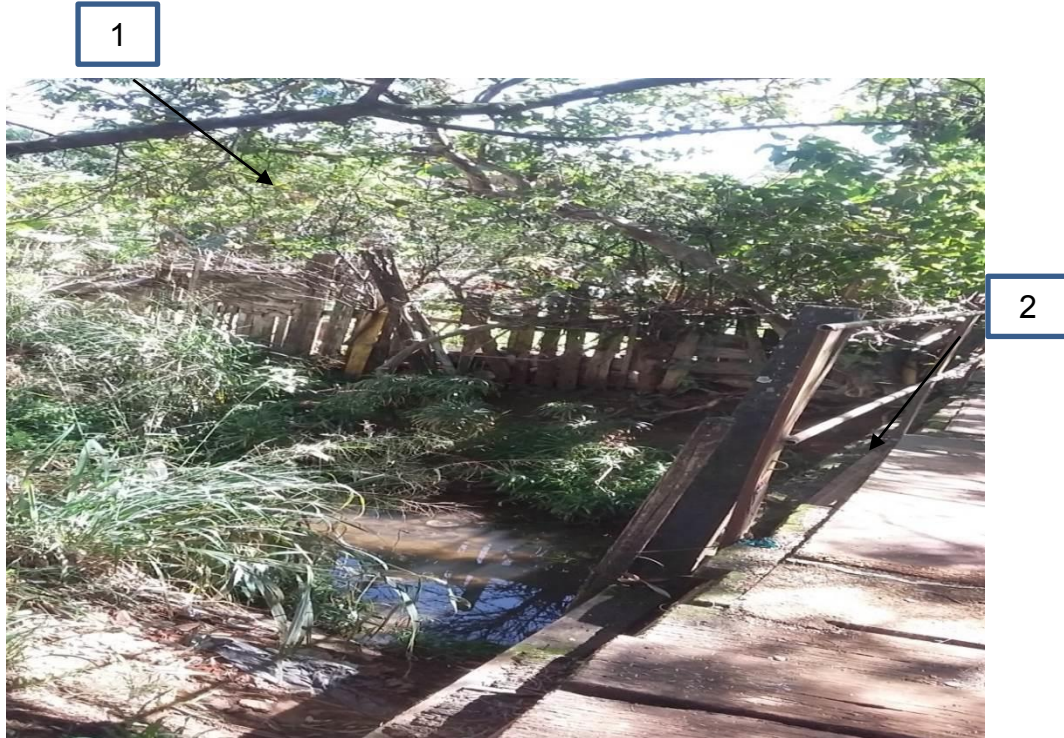
Figura 38 – UP1 e UP3-SUB3. Ponte sobre o Córrego Água das Pedras e Favela Pindorama
