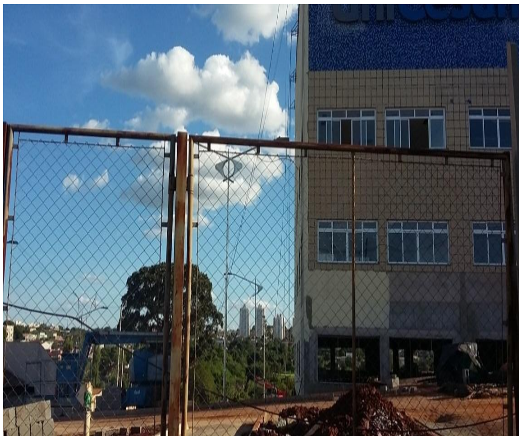
Figura 29 – Prédio em construção da Unicesumar
