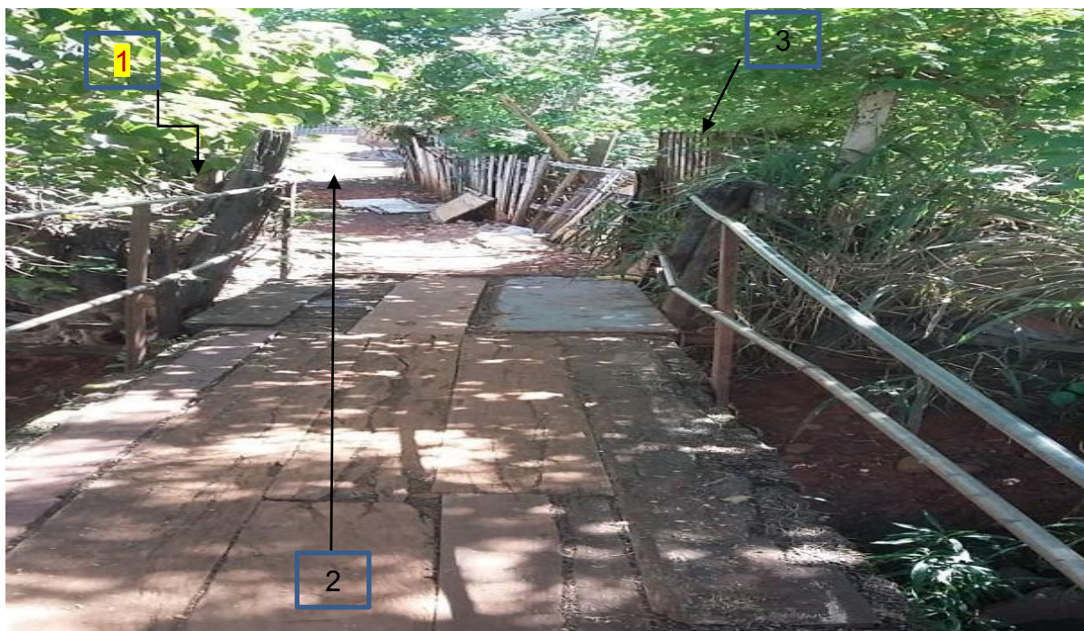
Figura 13 – Ponte sobre o Córrego Água das Pedras.
