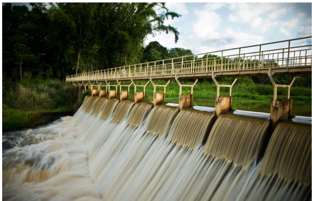
Figura 34 - Foto da barragem da mini-usina Três Bocas.
