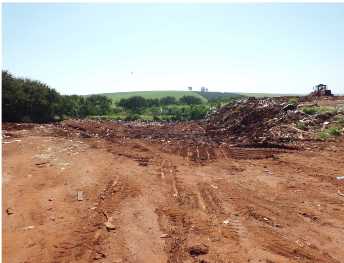
Figura 20 – Vista Parcial do Lixão do município de Florestópolis - 2013
