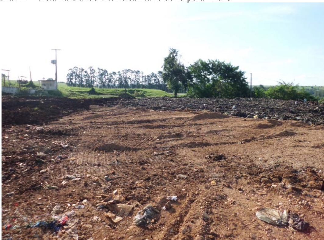
Figura 21 – Vista Parcial do Aterro sanitário de Ibiporã - 2013
