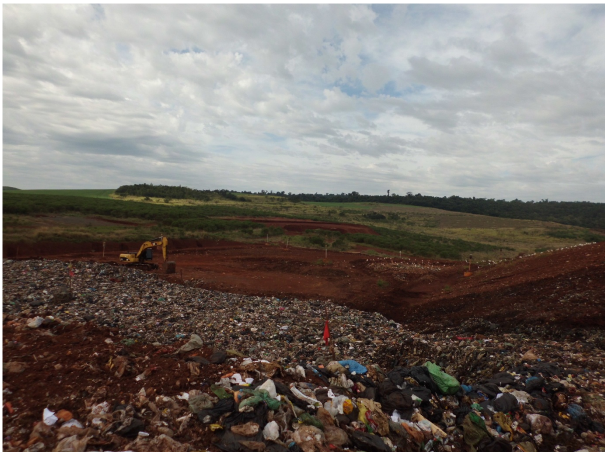
Figura 24 - Vista Parcial do Aterro Sanitário de Londrina - 2013
