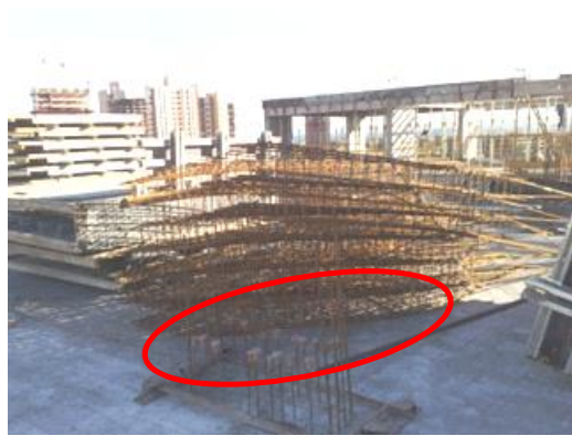
Figura 26: Pilha de armaduras depositadas sobre o arranque do pilar
