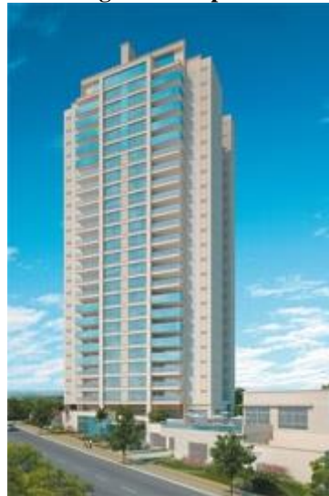
Figura 19 - Imagem do empreendimento CIP
