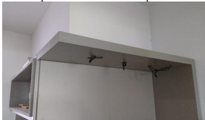
Figura 12 – Peça em balanço instalada com o reforço interno
