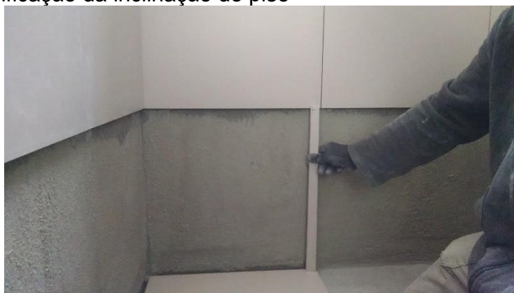
Figura 22 – Verificação da inclinação do piso
