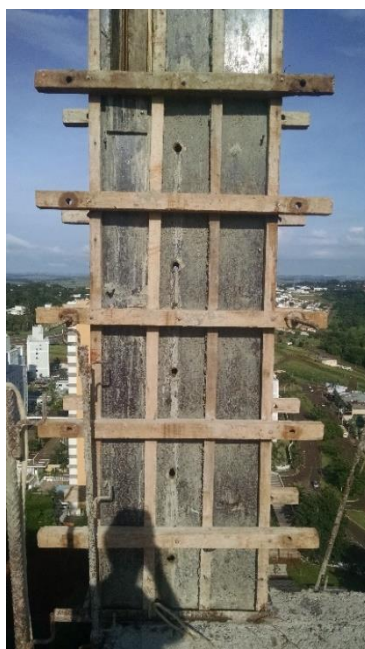
Figura 33 – Montagem das formas até a colocação dos primeiros tensores nas laterais
