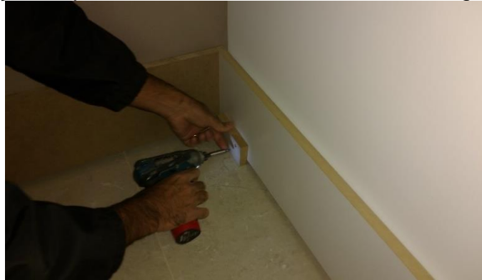
Figura 13 – Reforço do apoio da base com o auxílio de um tarugo de madeira
