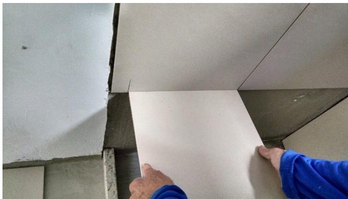
Figura 20 – Demonstração da exatidão do recorte da peça devido à simulação da peça no local
