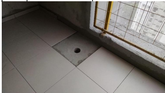
Figura 27 – Execução do piso diamantado após o assentamento do restante da área
