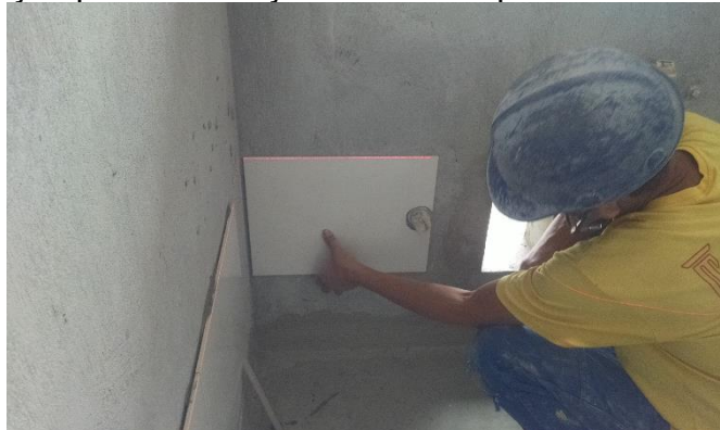
Figura 18 – Simulação para verificação do furo do ponto hidráulico
