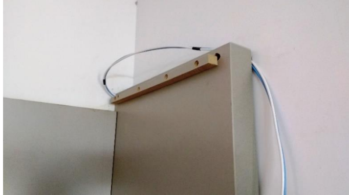
Figura 11 – Tarugo instalado para reforçar a fixação da peça em balanço
