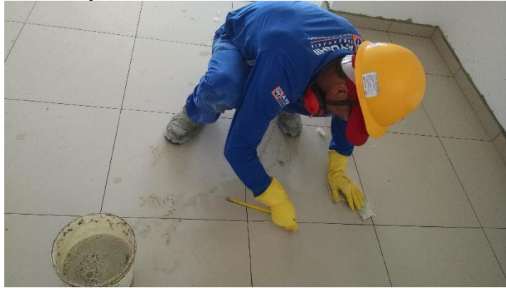
Figura 31 – Limpeza das juntas
