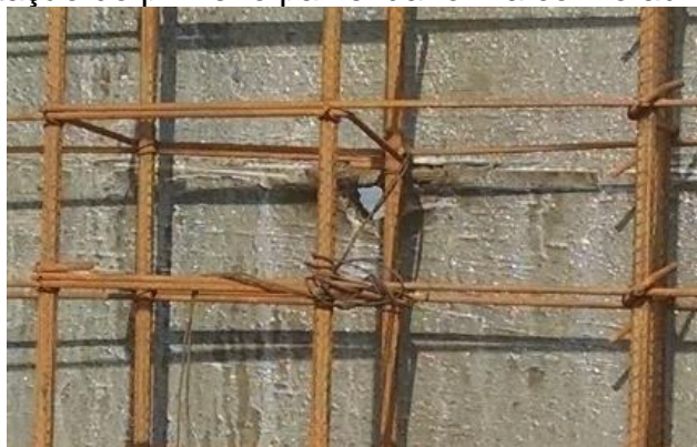
Figura 32 – Sustentação do primeiro painel da forma com o auxílio de um arame
