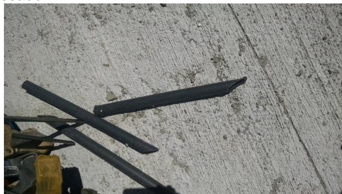
Figura 35 – Formato do tubo após o corte, em que uma das extremidades é enviesado
