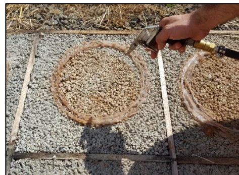
b) Limpeza das placas
