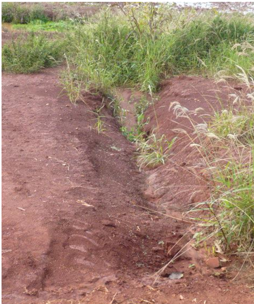
Figura 29 - Erosão em sulcos em latossolo – Região do Baixo Tibagi –Paranagi- Distrito de Sertaneja Foto: Ciciliato, (2009)
