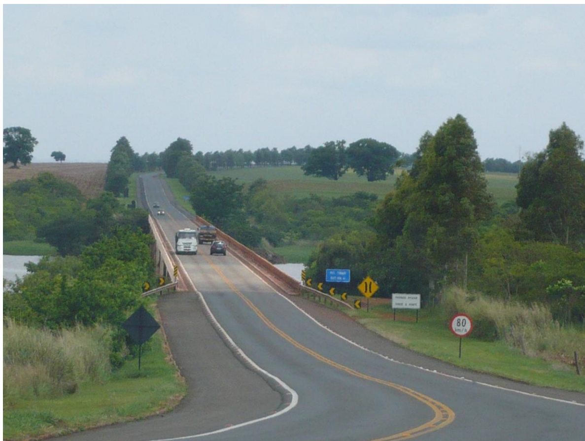
Figura 39 - Ponte sobre o Rio Tibagi – Início Geográfico da Região Metropolitana de Londrina- RML
