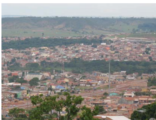
Fotografia 18 – Visão parcial de São Sebastião
