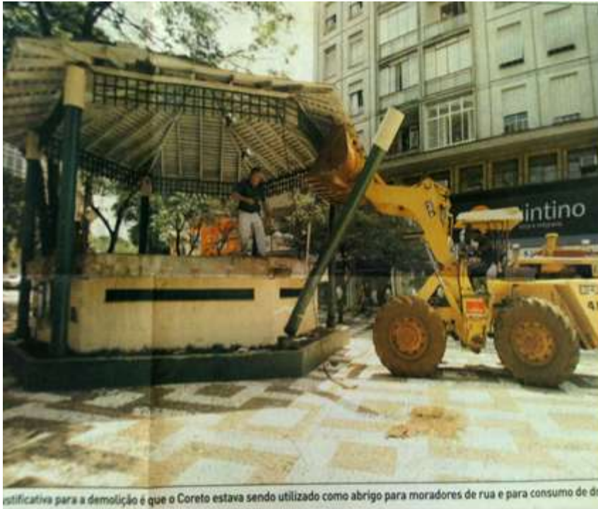
Figura 34 – Coreto no Calçadão sendo demolido
