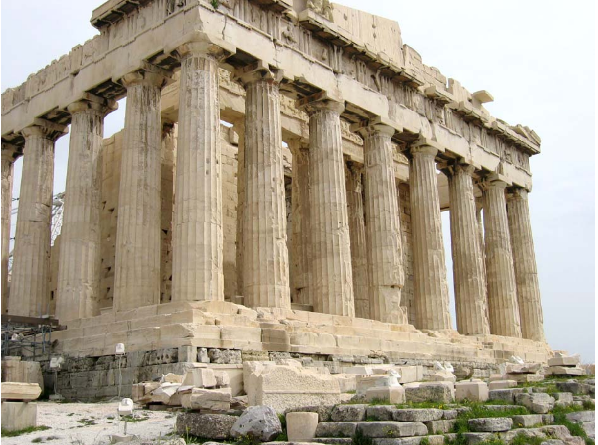
Figura 02 – Parthenon, arquitetura grega do século V a. C.
