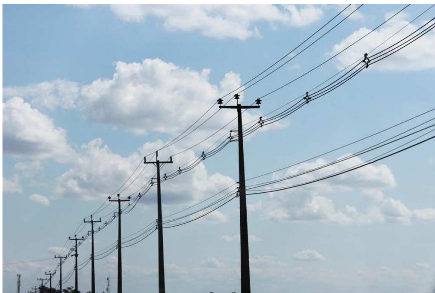
Figura 2.1: Exemplo de poste para ancoragem de cabos em redes aéreas de distribuição e transmissão de energia elétrica. Fonte: Click Guarulhos.
