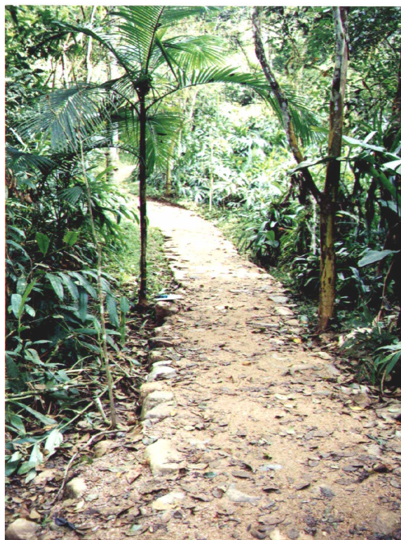
Foto 20 Trilha feita com 1,20 metros de largura, construída com seixos do rio soldados com argamassa e recoberta com cascalho retirado do rio.
