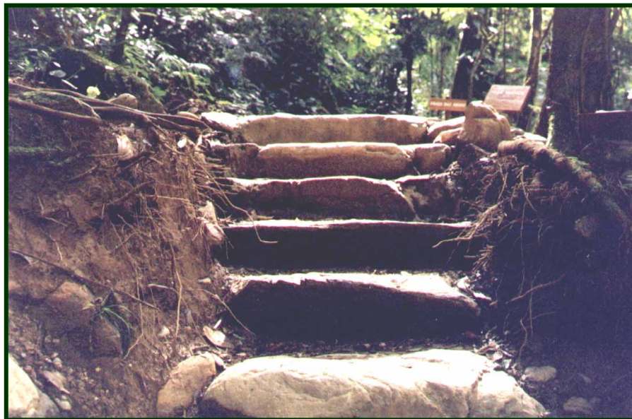
Foto 27 Degraus construídos à saída da passarela de seixos. Para a construção, o barranco foi cavado e a árvore à direita foi a mais afetada pela exposição de raízes.
