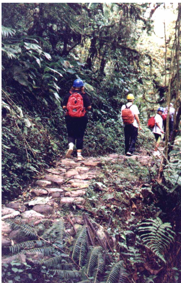
Foto 28 Em trecho depois do rio, trilha com cobertura de seixos e blocos feito há alguns anos. Largura suficiente para um pedestre
