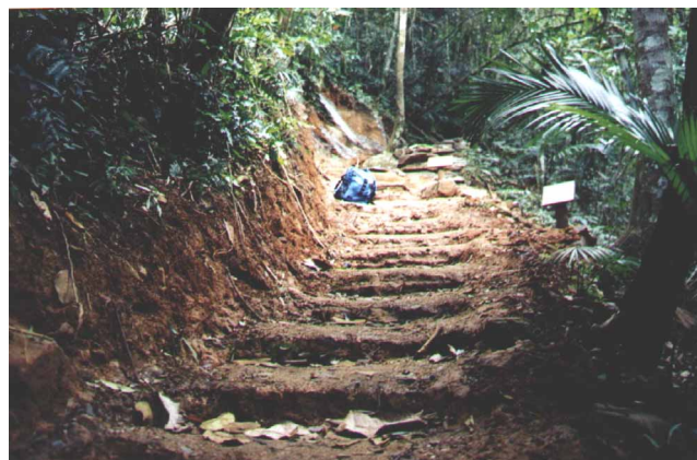
Foto 22 e 23 Degraus cavados no solo com escavação de barranco que expôs raízes que sustentam o solo à jusante da drenagem. Procedimento acarreta riscos de escorregamento de massa e pouca durabilidade dos degraus, que se desfazem com o pisoteamento.
