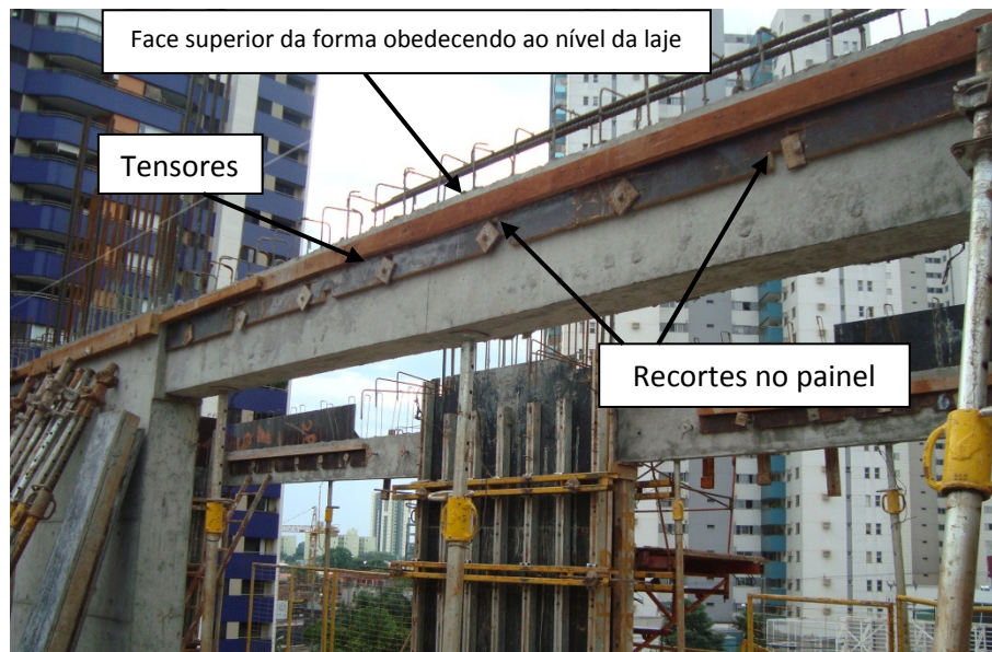
Figura 17 - Vista dos painéis de formas de bordas
