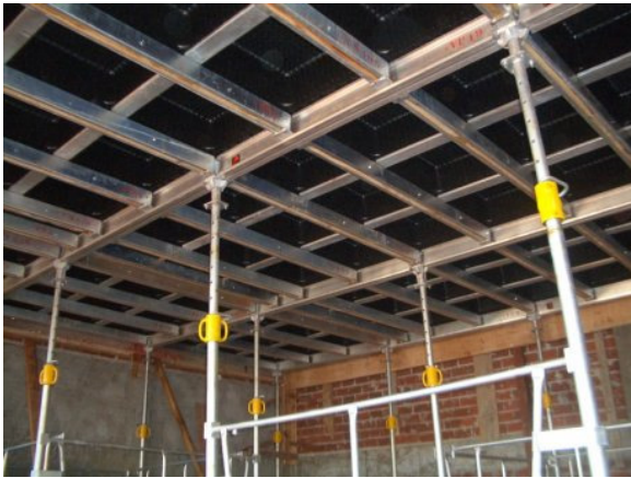
Figura 8 - Sistema de escoramento
