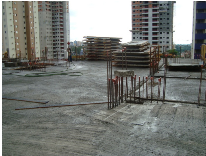
Figura 22 - Limpeza na área de trabalho e armazenagem de formas no pavimento
