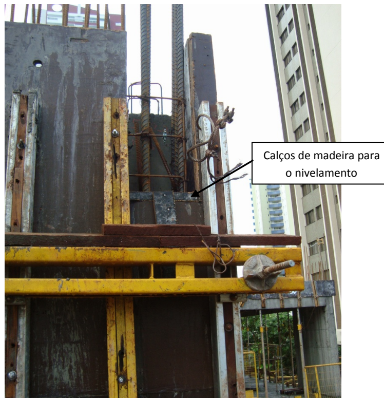
Figura 18 - Procedimento utilizado para nivelamento das formas na região de encaixe de pré-vigas
