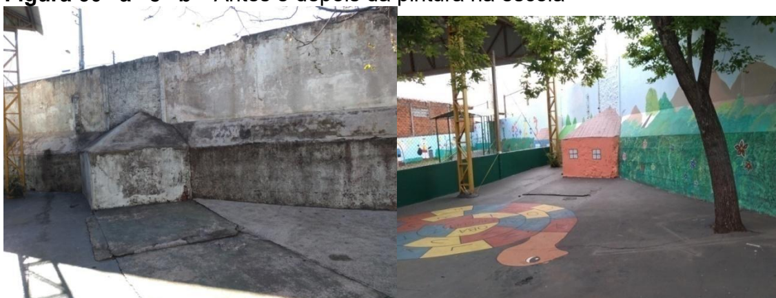
Figura 60 “a” e “b” - Antes e depois da pintura na escola
