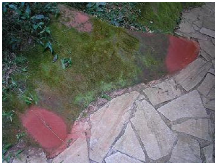
Figura 73 – Desgaste erosivo na lateral da atual trilha dos arenitos. Foto: RETZLAF, 2006.
