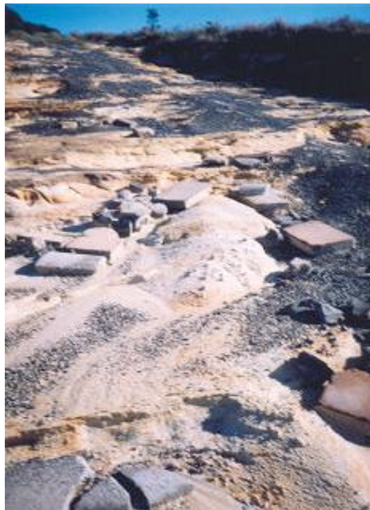
Figura 54 – Trecho bastante erodido na porção inferior da antiga estrada municipal. Foto: RETZLAF, 2004
