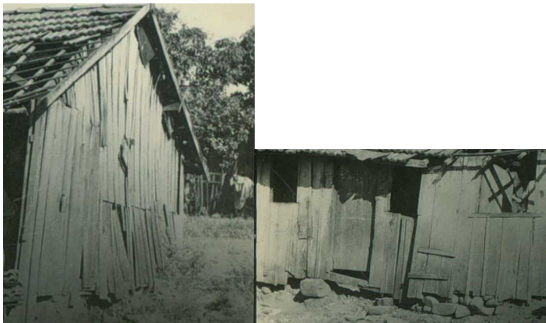
Figura 32 - Demolição de casa na Vila Fraternidade - Estrutura da casa (Recorte)
