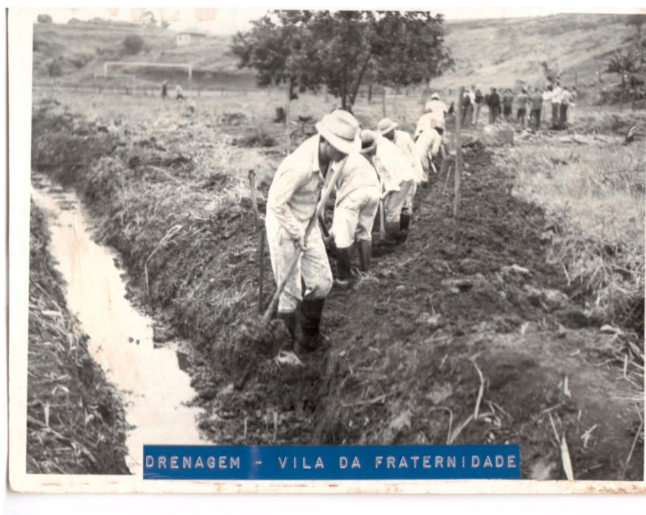
Figura 42 - Drenagem - Vila da Fraternidade
