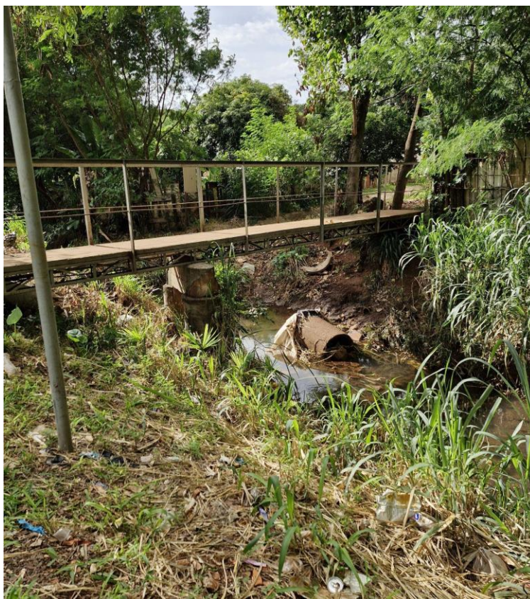
Figura 43 - Córrego da rua Flor-de-Jesus com a rua Santa Terezinha, 13 de fevereiro de 2024
