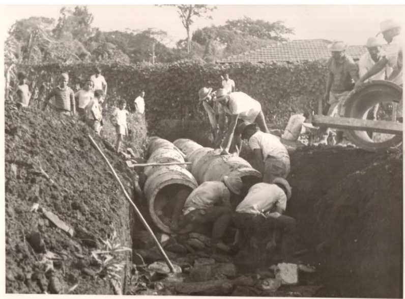
Figura 47 - Instalação de tubulações na Vila Fraternidade, década de 1970
