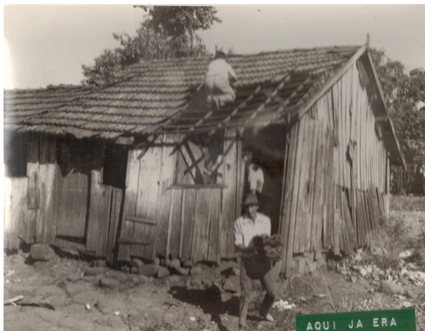
Figura 33 - Demolição de casa na Vila Fraternidade, 15 de maio de 1971 (B)
