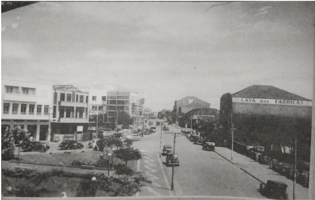
Figura 22 - Rua Maranhão e Avenida Paraná
