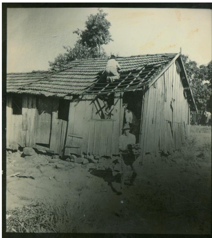
Figura 31 - Demolição de casa na Vila Fraternidade, 15 de maio de 1971 (A)
