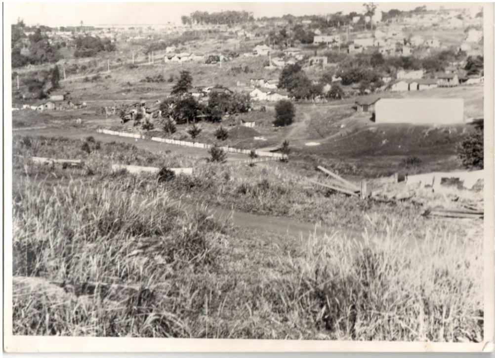
Figura 19 - Vista Parcial da Vila do Grilo/Vila Fraternidade, 15 de maio de 1971
