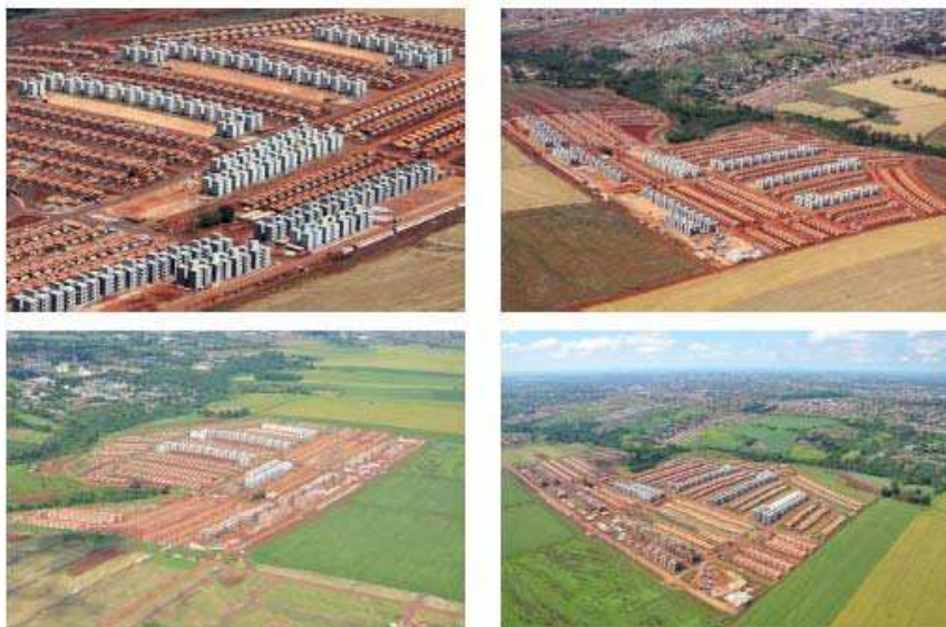
Figura 3 – Vista do Residencial Vista Bela
