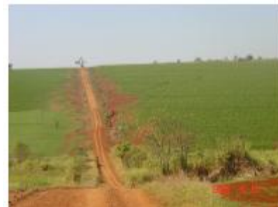
Figura 48 – Foto de área com profundas feições erosivas à margem da estrada.
