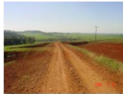
Figura 43 – Foto de murunduns usados para tentar conter a erosão próxima as estradas rurais.
