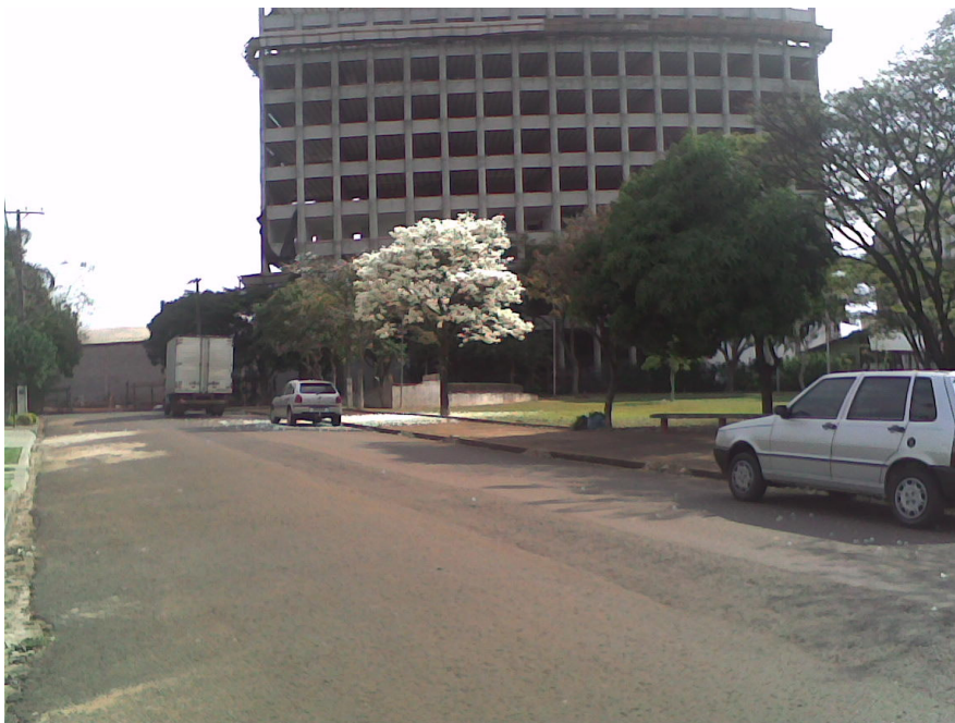
Foto 15 – Construção de um edifício Loft próximo a Avenida Madre Leônia Milito. Fonte: Andresa Lourenço.
