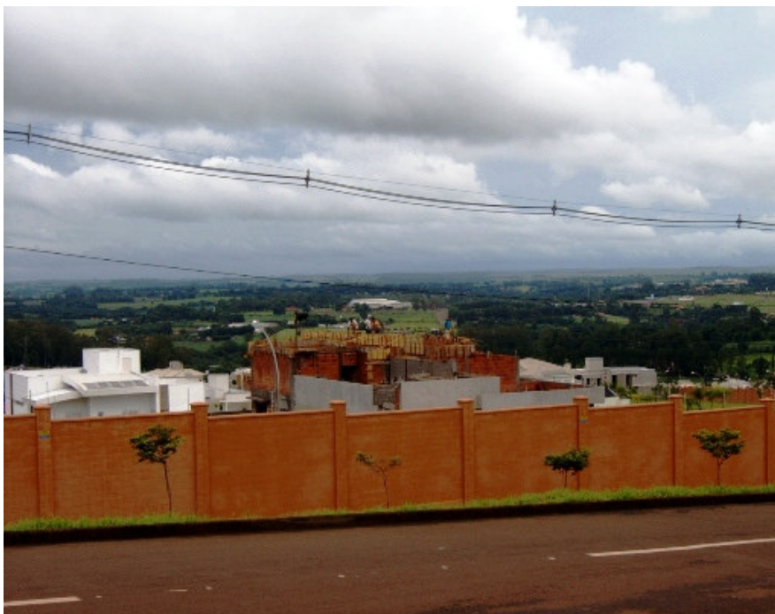
Foto 12- Panorâmica do Condomínio Alphaville, em destaque várias casas em construção. Fonte: Andresa Lourenço.
