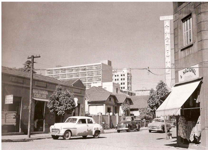
Foto – 09 Cenas do cotidiano de Londrina (1950), ao fundo prédios em construção, e à frente casas comerciais do lado de residências de madeira. Fonte: Acervo do Foto Estrela.
