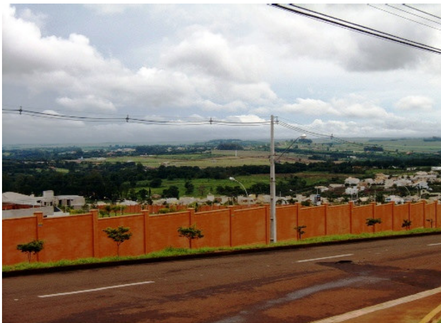
Foto 13 – Vista lateral do condomínio Alphaville, do lado direito da rua fica o shopping Catuaí. Fonte: Andresa Lourenço.
