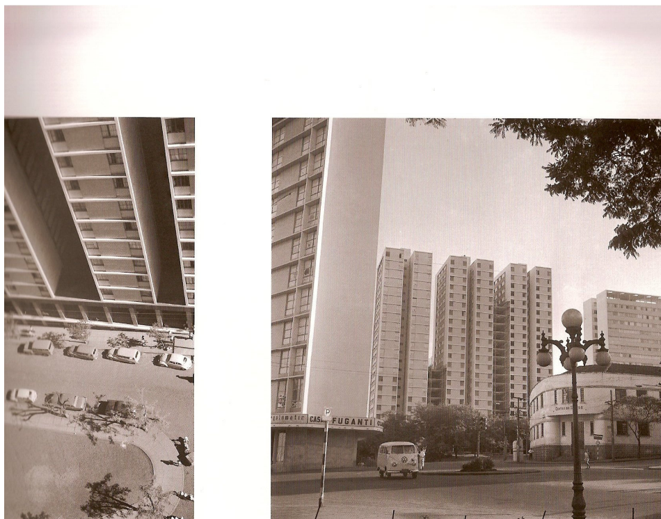
Foto 11 – Vista área do edifício Julio Fuganti, em frente do posto de saúde municipal, na Rua Senador Souza Naves. Ao fundo os edifícios do centro comercial.
