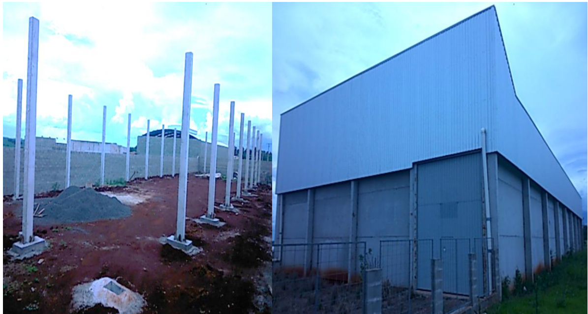
Figura 17 – Galpão Industrial Pré-moldado – Obra 9.
