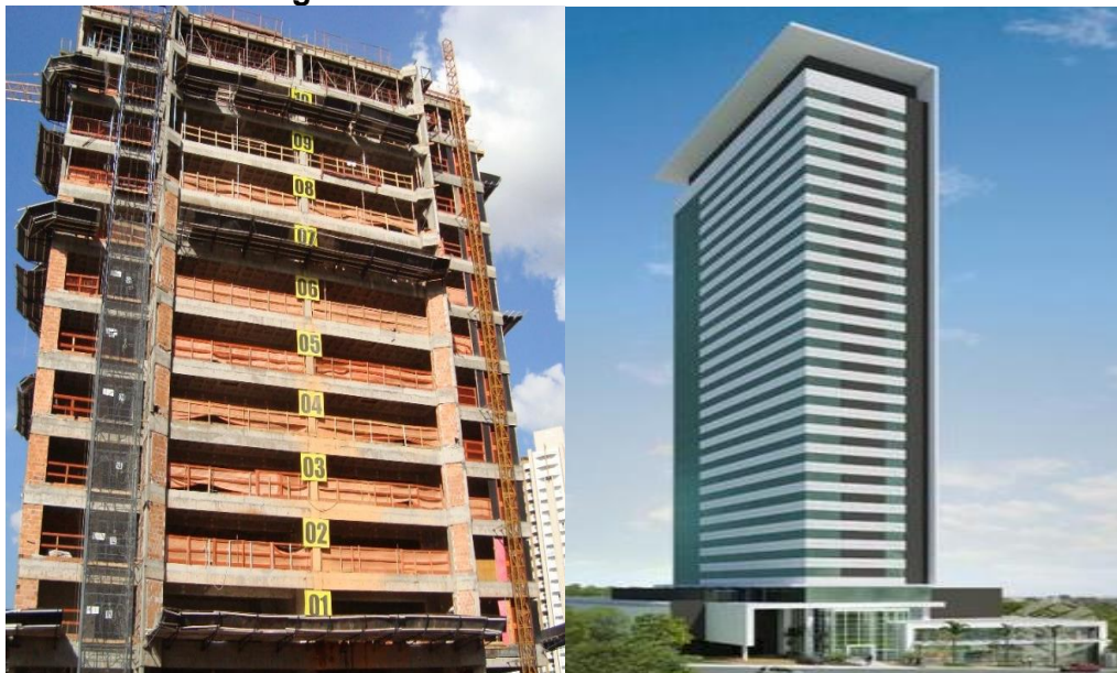
Figura 18 – Edifício Comercial – Obra 10.
