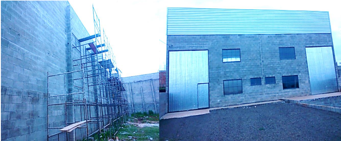
Figura 15 – Galpões Industriais Executados em Alvenaria Estrutural – Obra 7 e 8.
