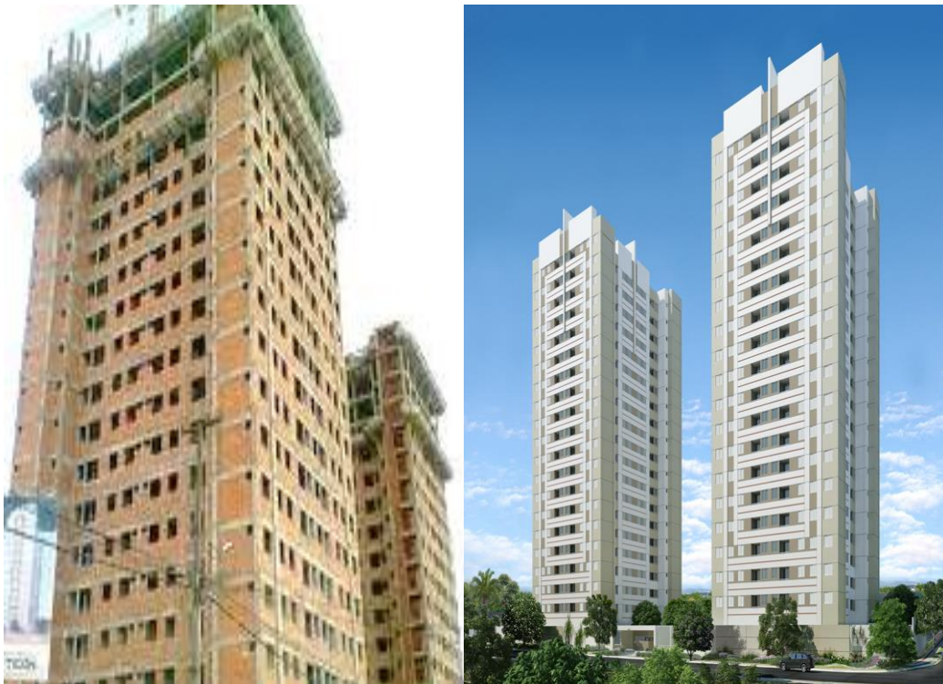
Figura 9 – Edifício Residencial Multifamiliar – Obra 2.
