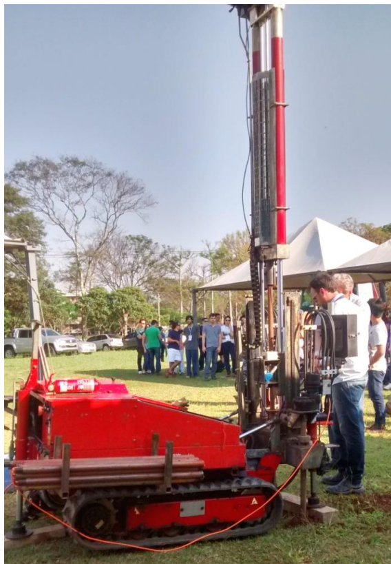
Figura 22 – Execução do ensaio de CPT no Campo Experimental da UEM.
