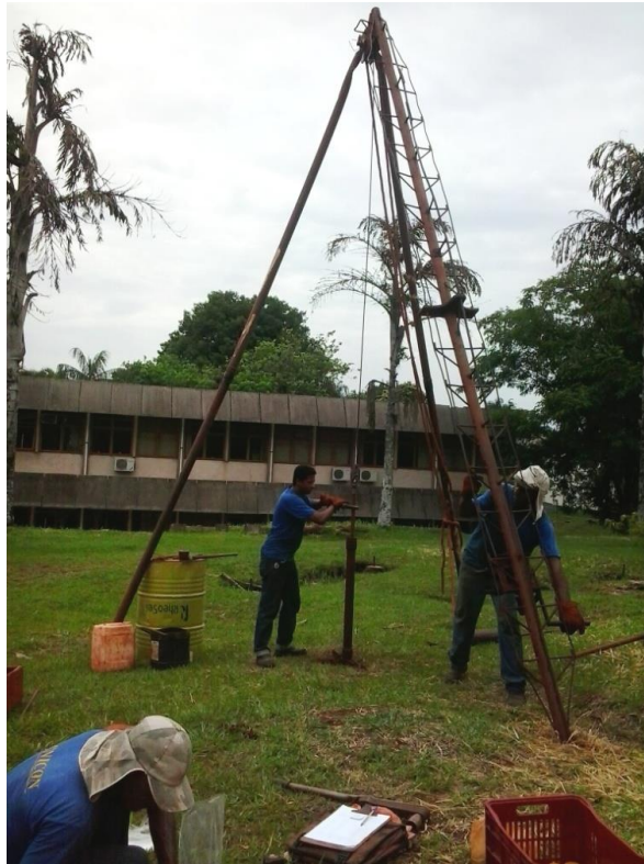
Figura 21 – Execução do SPT-T no CEEG.
