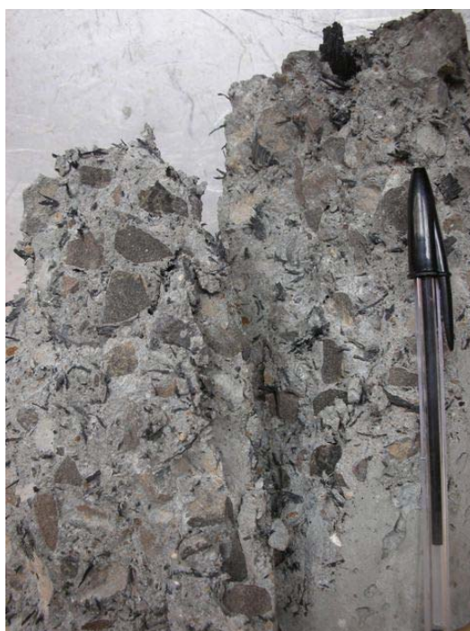
Figura 51 – Corpo de prova rompido em ensaio à compressão
