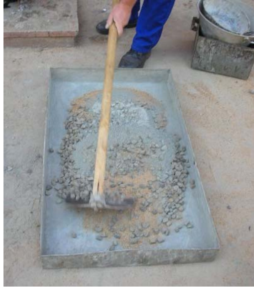
Figura 49 – Mistura manual dos materiais
