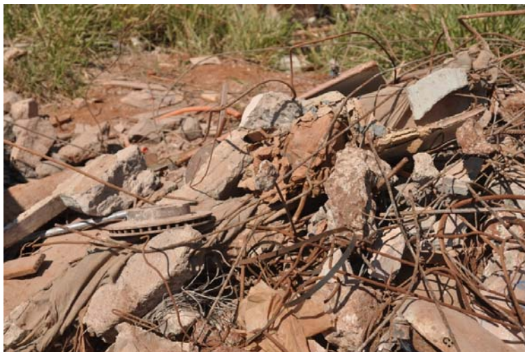
Figura 45 – Resíduos da Construção Civil sem o beneficiamento
