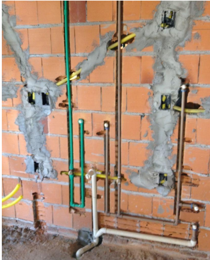
Figura 19 – prototipagem física para antecipar problemas de interferências entre subsistemas e incompatibilidades de projeto
