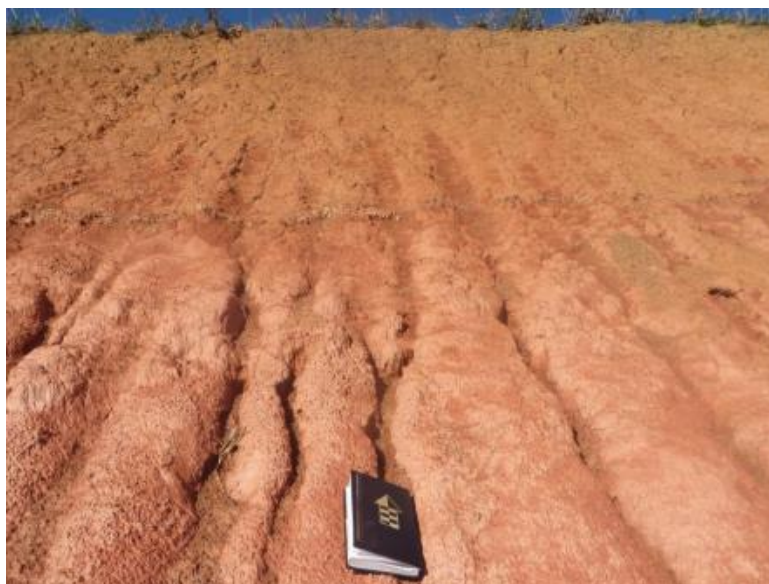
Figura 2 – Erosão em sulcos
