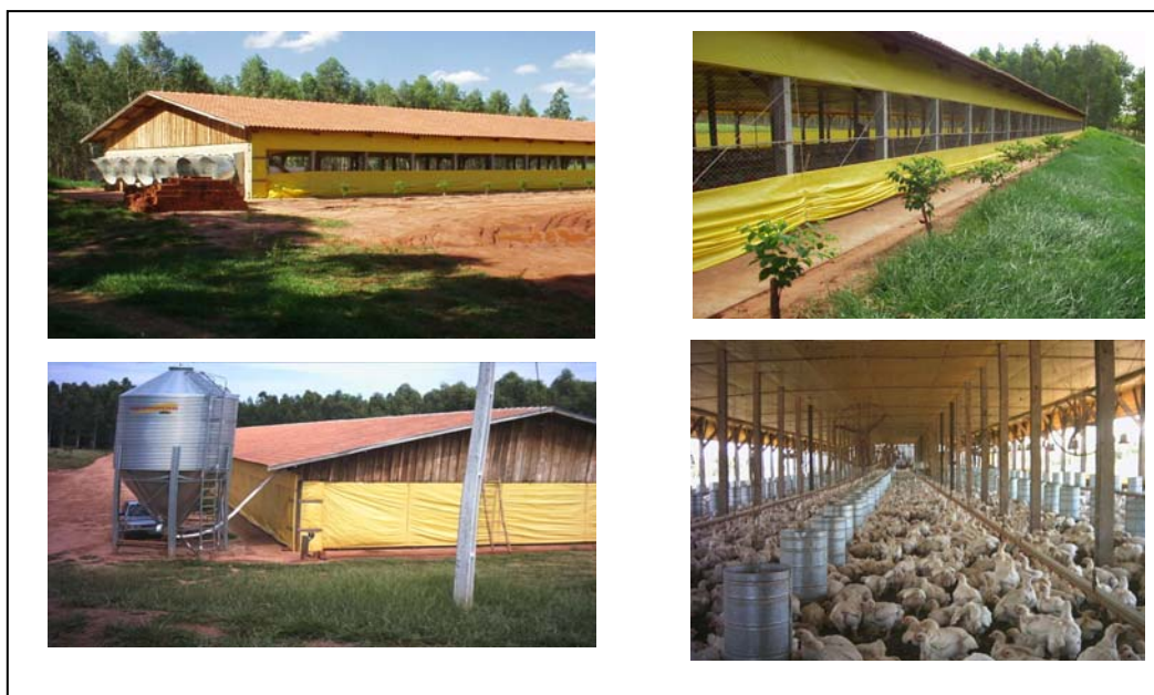
Figura 33 – Fotos de aviários modernos (comedouros, bebedouros e controle de temperatura automática são equipamentos padrões para os projetos atuais). Fonte: Avícola Felipe S/A.
