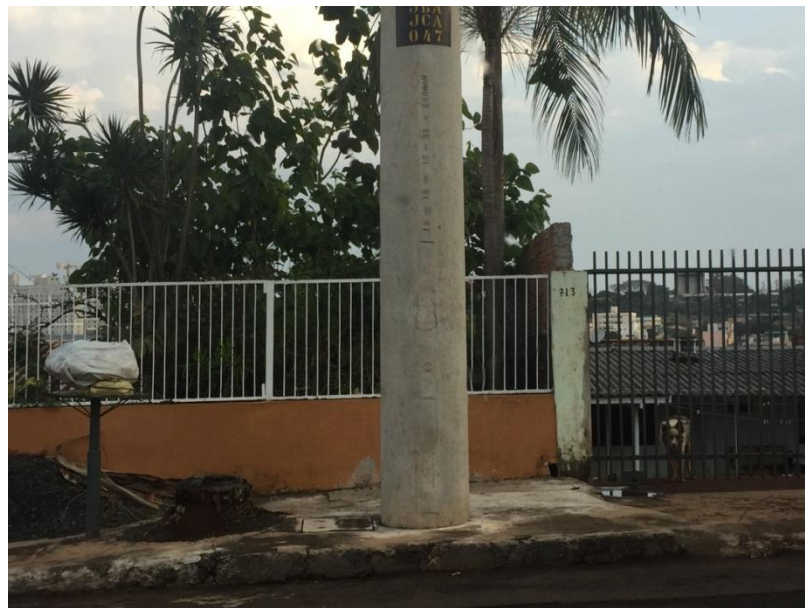
Figura 2 – Superpostes – Rua Francisco Alves Sobrinho
