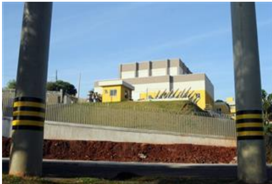
Figura 1 – Subestação Jardim Canadá
