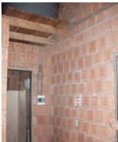
Figura 13 – Recorte na alvenaria.
