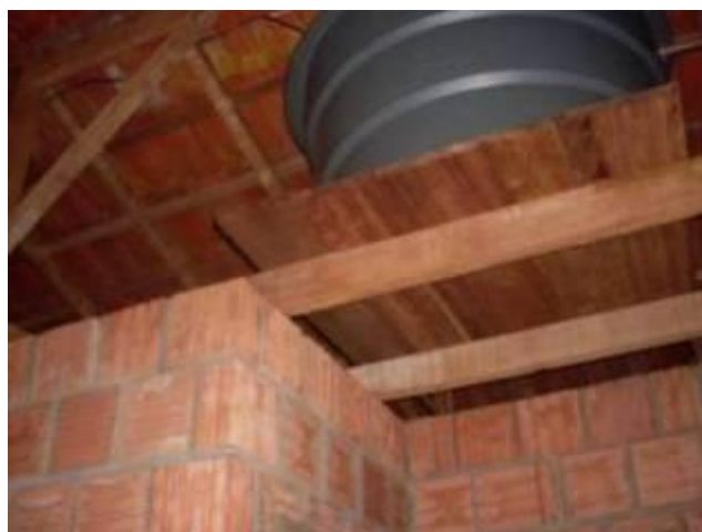
Figura 14 – Detalhe da Caixa d'água interna.
