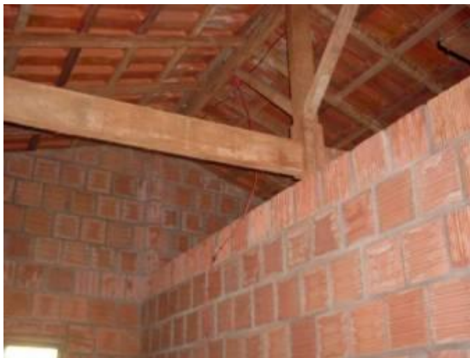
Figura 15 – Estrutura de cobertura.
