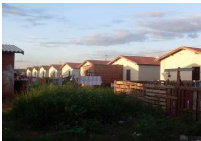
Figura 11 – Cerca de divisa e ampliação de uma residência no conjunto.
