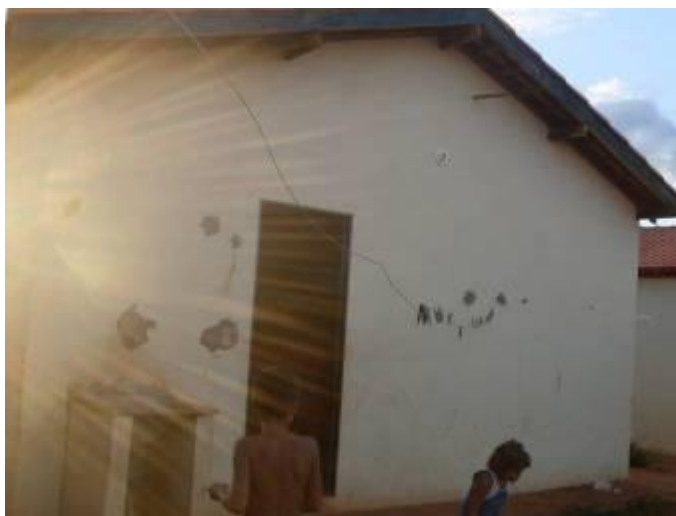
Figura 7 – Área de serviço (fundo da edificação)
