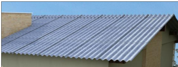
Figura 47 – Exemplo de uma cobertura residencial
