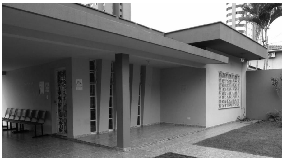
Figura 89 - Residência D2 - Quadra 97 - Rua Pombas x Harpia
