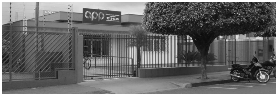
Figura 42 - Residência I - Quadra 11 - Rua das Garças
