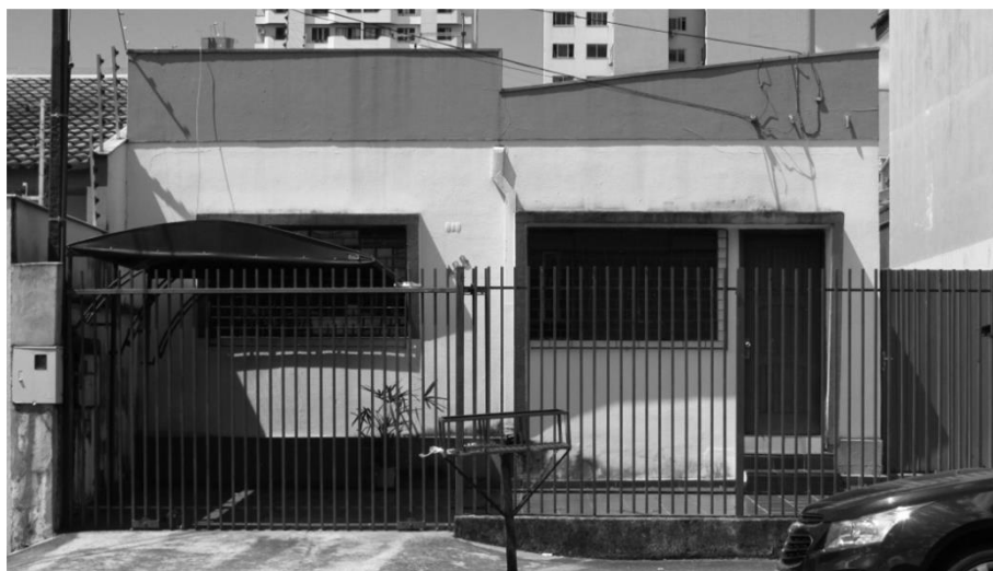
Figura 99 - Residência N2 - Quadra 112 - Rua Pica-Pau - unidade nº 108
