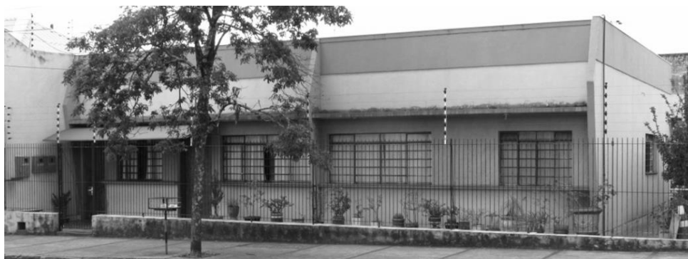
Figura 44 - Residência K - Quadra 15 - Rua Jacutinga
