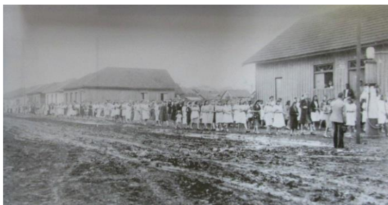
Figura 4 - Edificações de madeira na década de 1940
