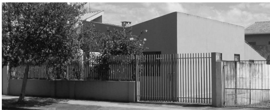
Figura 104 - Residência S2 - Quadra 126 - Rua Pica-Pau
