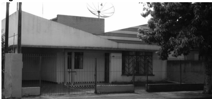
Figura 107 - Residência V2 - Quadra 137 - Rua Para-Piri
