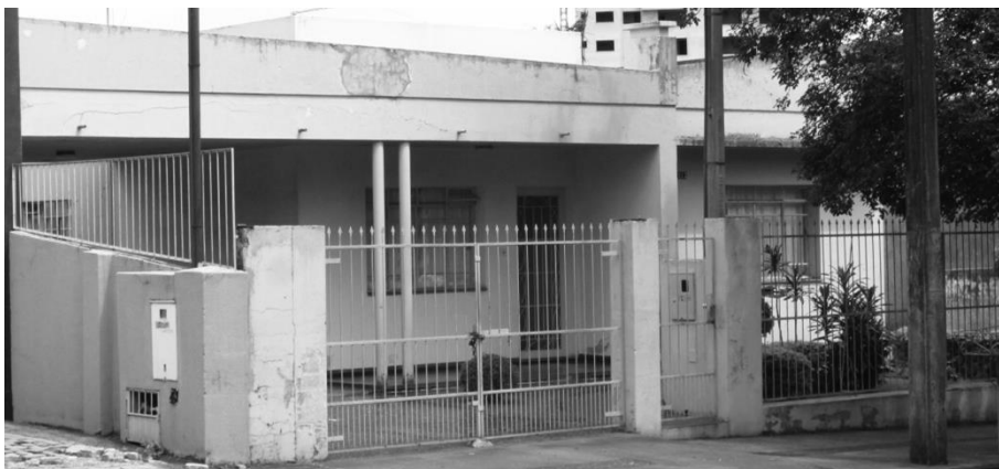
Figura 73 - Residência N1 - Quadra 52 - Rua Condor
