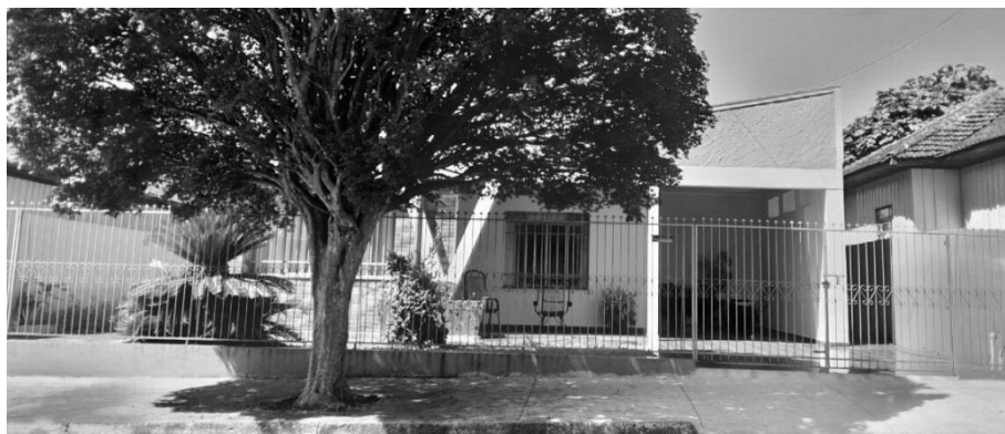
Figura 88 - Residência C2 - Quadra 97 - Rua Pombas
