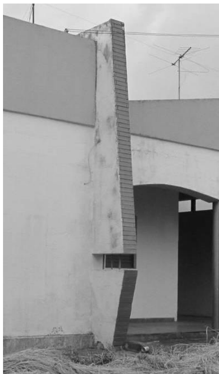
Figura 114 - Elemento chanfrado - Rua das Garças
