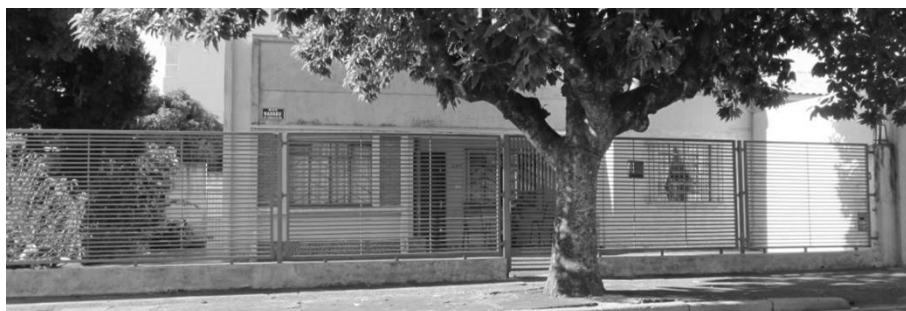
Figura 72 - Residência M1 - Quadra 61- Rua Marabu x Rua Falcão
