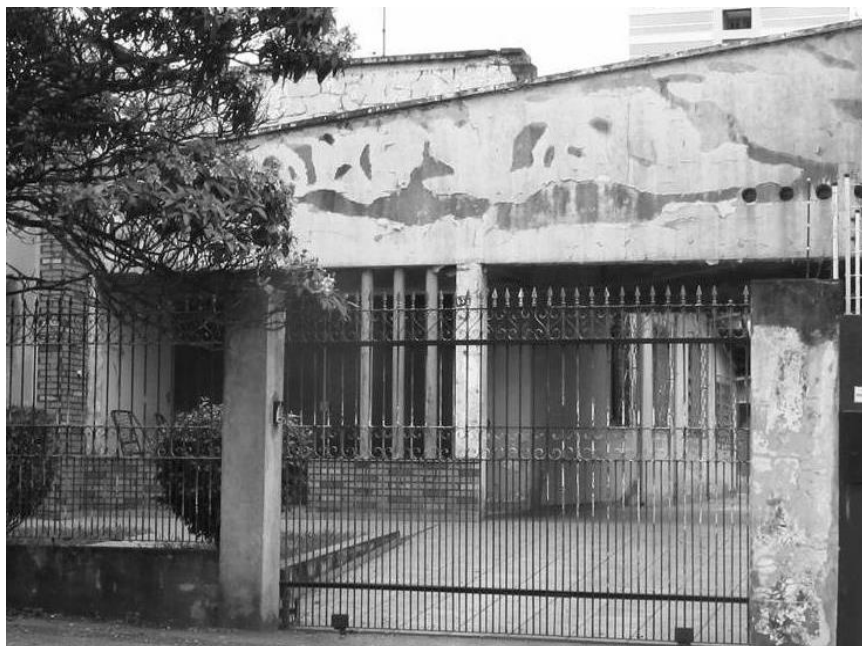
Figura 115 - Elemento vazado circular a direita da platibanda - Residência nº 73
