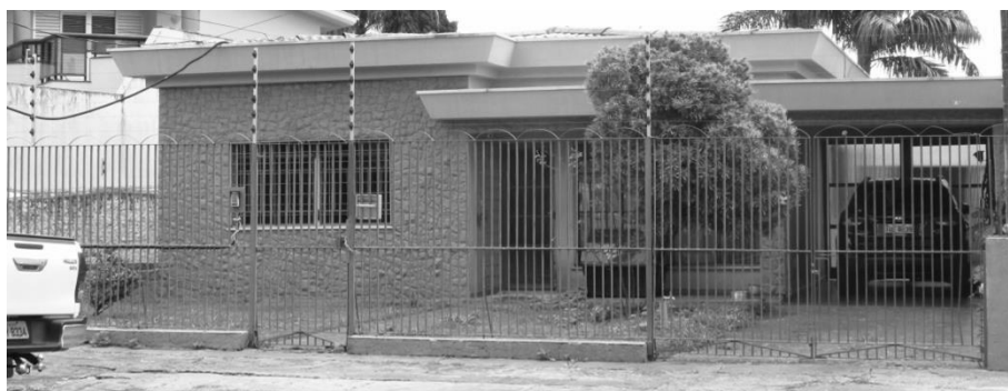
Figura 86 - Residência A2 - Quadra 95 - Rua Ibis
