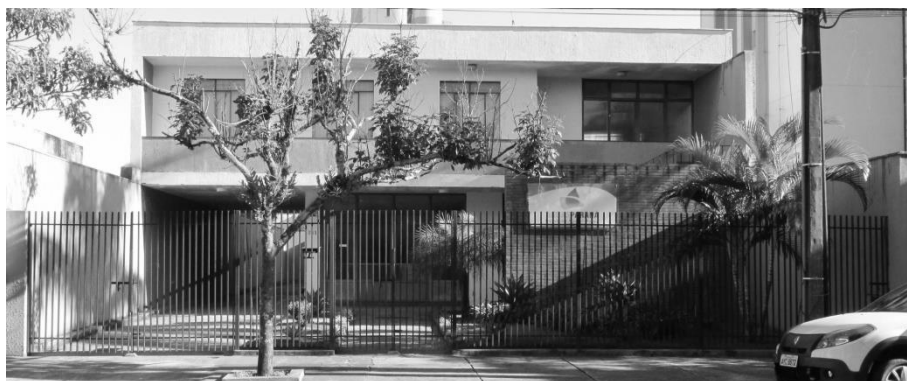
Figura 59 - Residência Z - Quadra 45 - Rua Marabu
