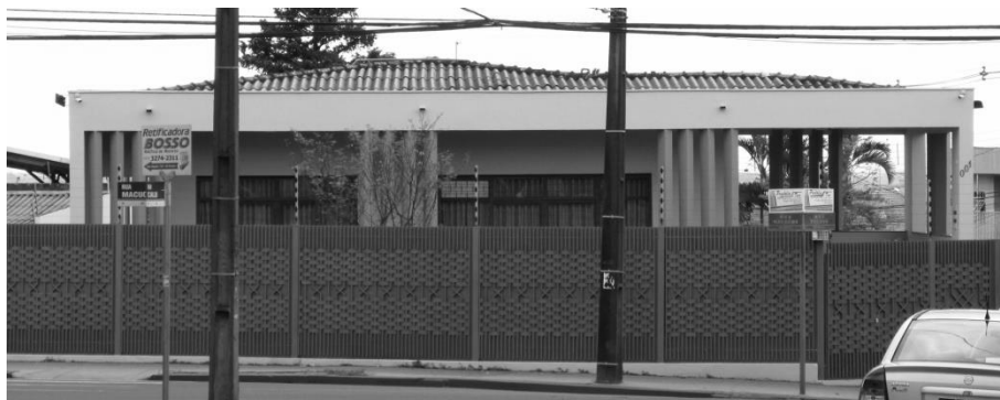
Figura 103 - Residência R2 - Quadra 122 - Rua Macucos
