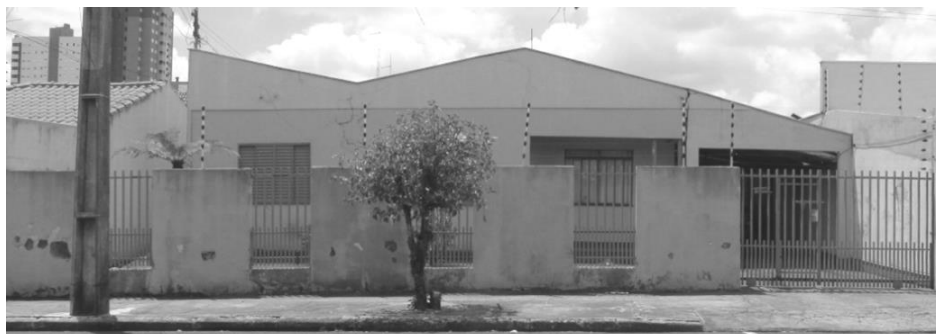
Figura 82 - Residência X1 - Quadra 71- Rua Pavão
