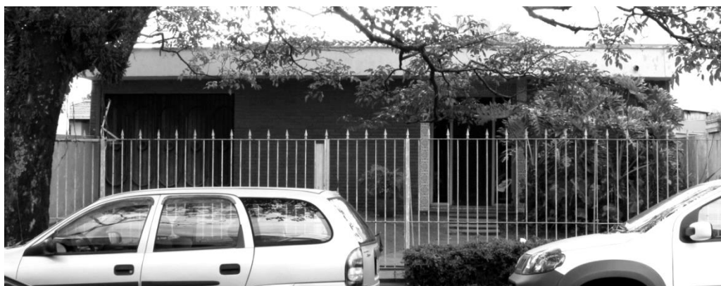
Figura 34 - Residência A - Quadra 01 - Rua Avestruz
