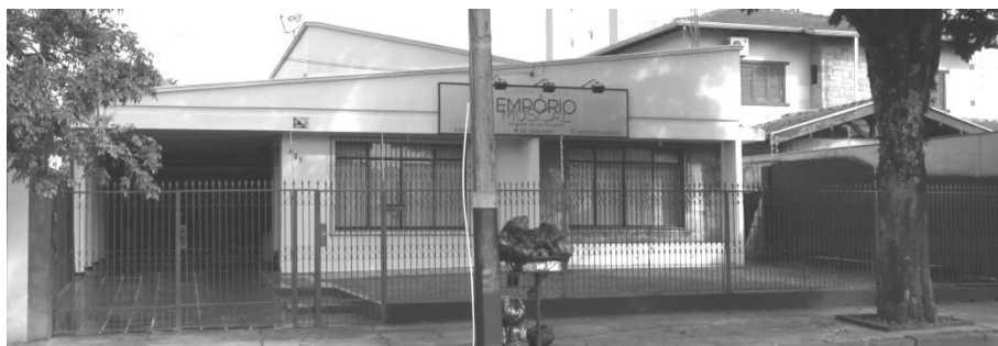
Figura 55 - Residência V - Quadra 39 - Rua Falcão
