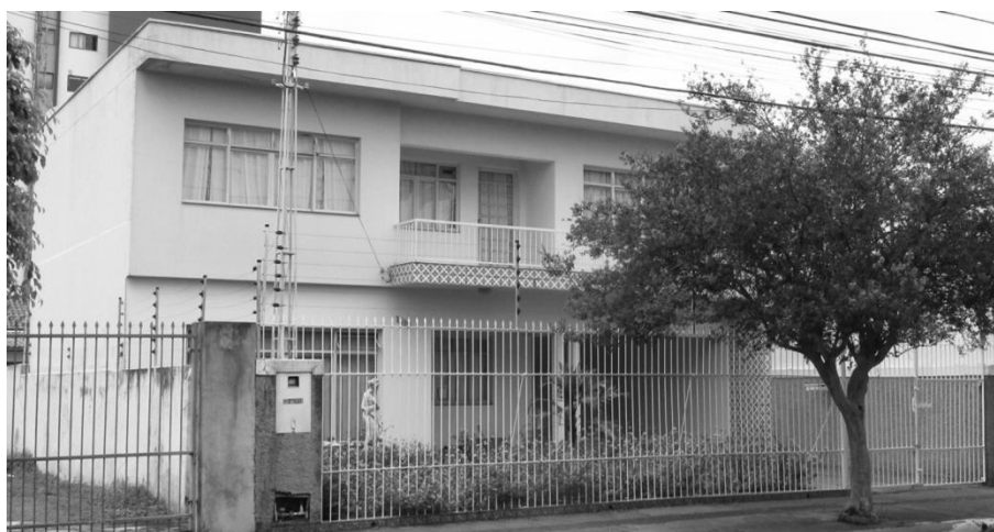
Figura 57 - Residência Y - Quadra 43 - Rua Drongo
