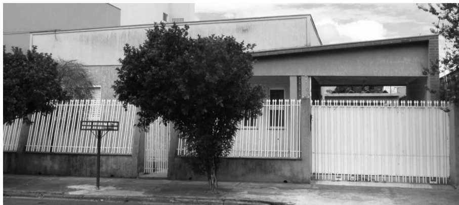
Figura 98 - Residência M2 - Quadra 111- Rua Beija-Flor
