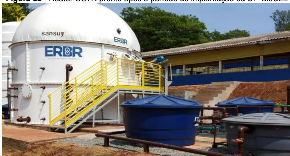
Figura 52 - Reator CSTR pronto após o período de implantação da UP-BioUEL
