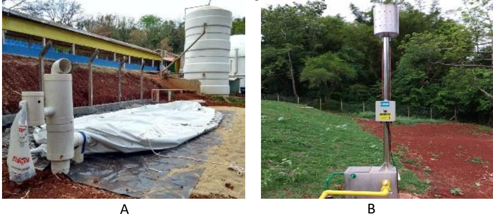
Figura 49 - Instalação do gasômetro (A) e flare (B)
