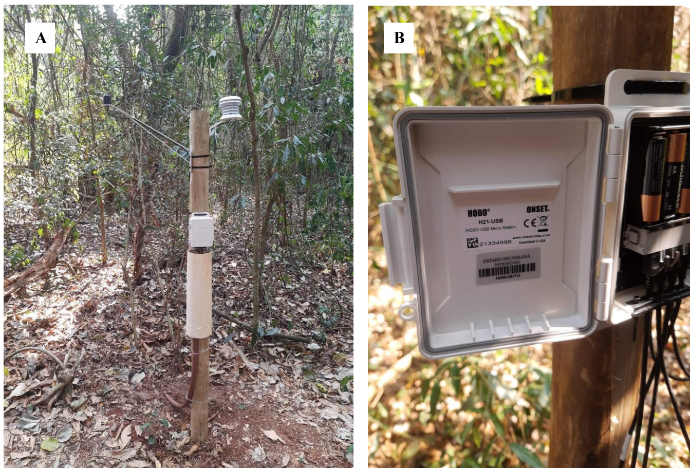
Figura 3 - Estrutura montada da estação microclimática, mostrando os sensores e os materiais de proteção (3A); Micro estação HOBO em funcionamento (3B).
