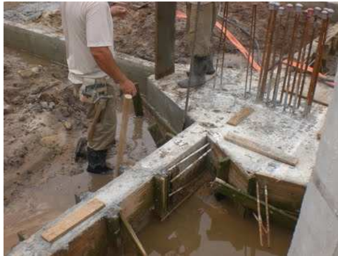
Figura 2.10: Bloco de coroamento concretado.
