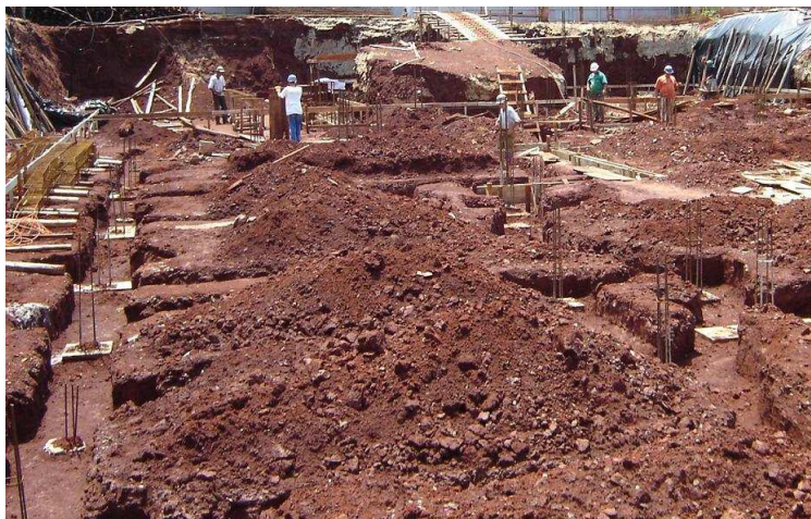
Figura 2.4: Escavações para baldrames.
