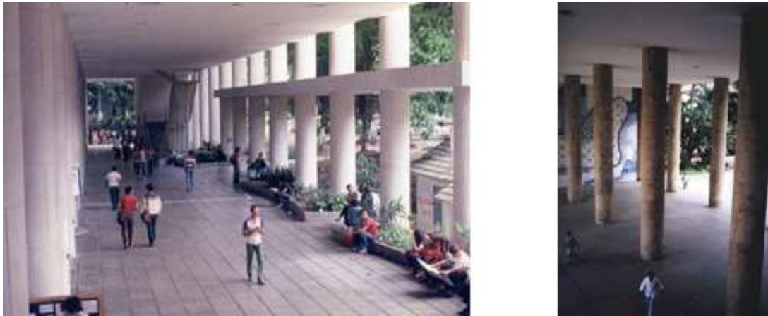
Figura 2.1: Pilotis: solução arquitetônica de pilares sem paredes.
