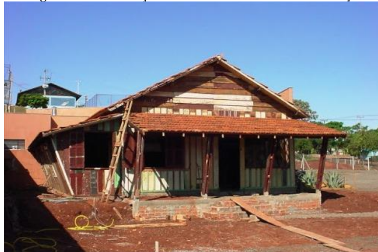
Figura 6 – Reconstrução da casa de madeira no novo endereço
