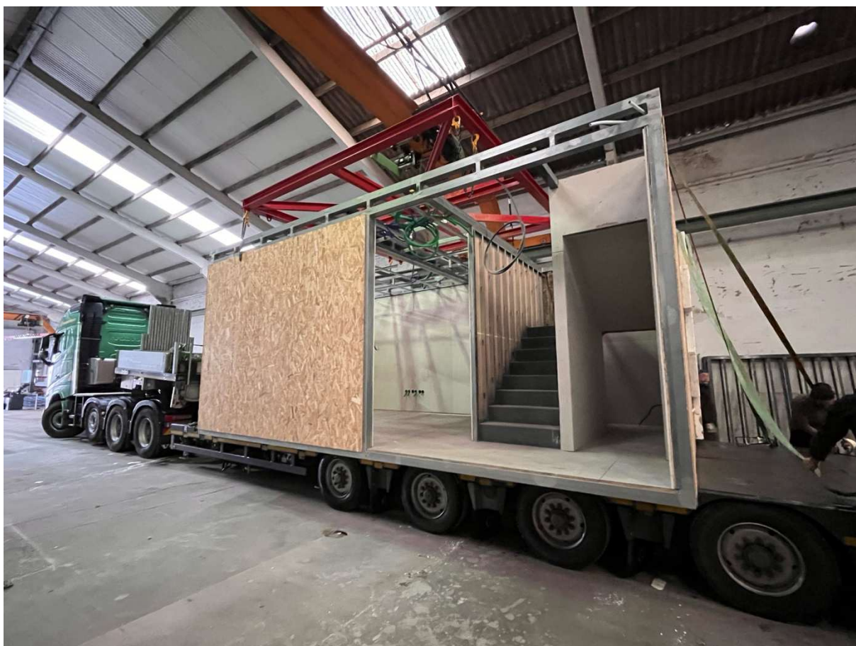
Figura 8 - Carregamento do módulo na unidade industrial
