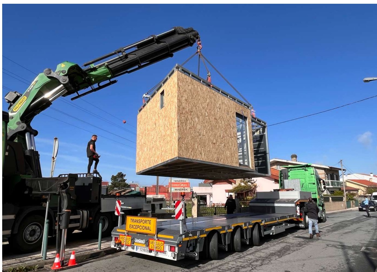
Figura 10 - Içamento do módulo com guindaste posicionado fora do terreno, sobrepondo o muro de divisa.
