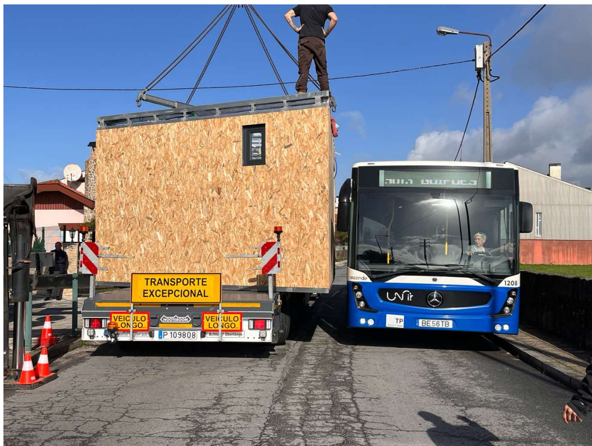
Figura 11 - Interferência na faixa de rolamento provocada pelo caminhão de transporte modular em trecho urbano.
